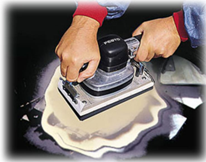
Fuente: www.pinturamastyle.com Figura 2.33: lijado y pulido.
