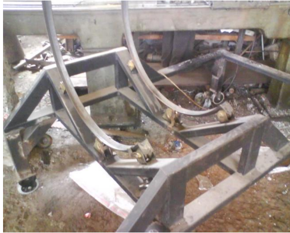
Figura 3.12 Rieles montados en el soporte
