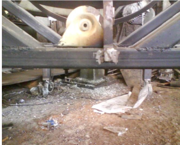
Figura. 3.10 Corredera principal montada en el soporte
