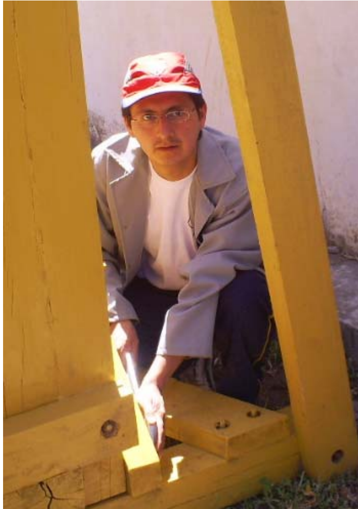
Figura 76. Reajuste de pernos Fuente: Pablo Herrera
