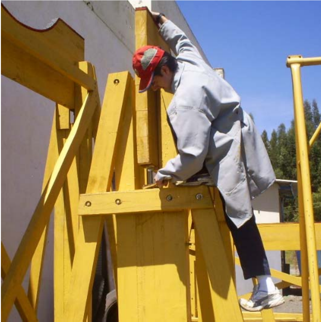
Figura 74. Colocación del mecanismo Fuente: Pablo Herrera
