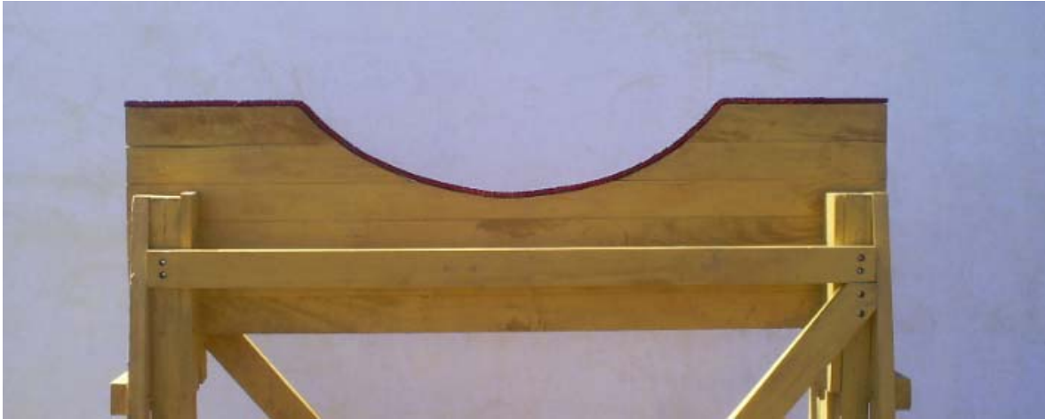
Figura 73. Ensamble del tablero
