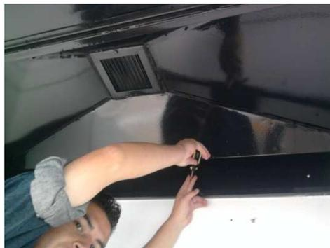
Figura 4.17 Aseguramiento de la campana de captación
