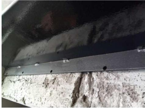
Figura 4.16 Montaje de la campana de captación
