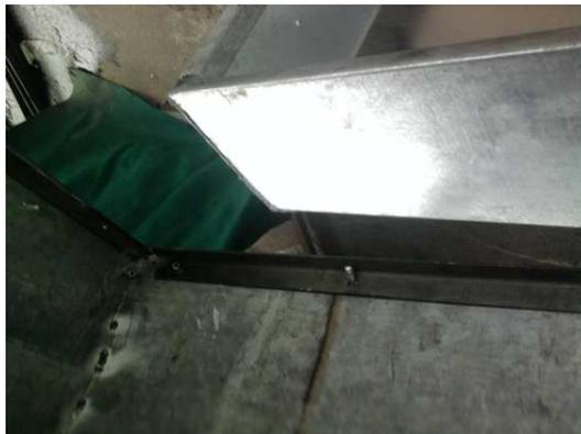
Figura 4.4 Estructura de la campana de captación
