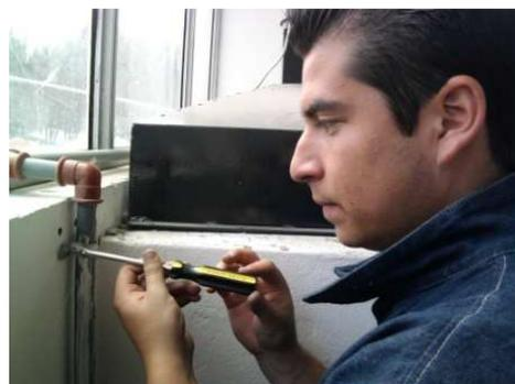
Figura 4.33 Aseguramiento de la cañería
