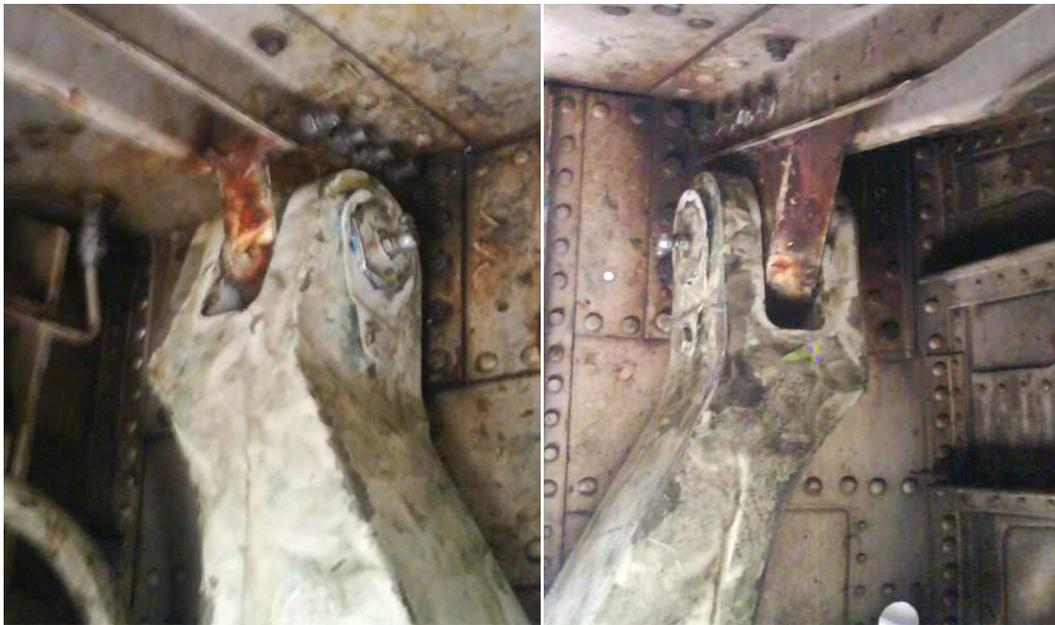
**Figura N.- 52** Pins asegurados y extremos roscados y la placa de cerradura de seguridad con tornillos y tuercas
