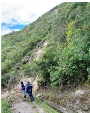
*Nota.* La figura muestra el deslizamiento superficial del talud en el canal de riego Palmares.
