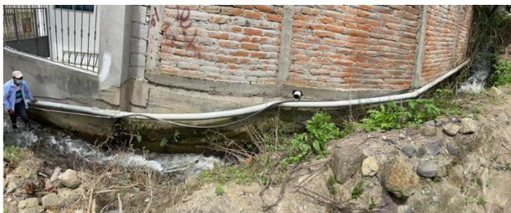
*Nota.* El Sistema de Riego Acequia Baja Alchipichí atraviesa determinados puntos en los cuales existen conexiones domiciliarias de desagüe que evacuan directamente al canal.
