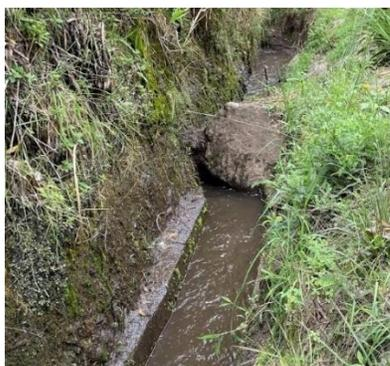
*Nota.* La figura muestra como la roca dentro del canal de riego Acequia Baja Alchipichí obstruye el flujo continuo del canal.
