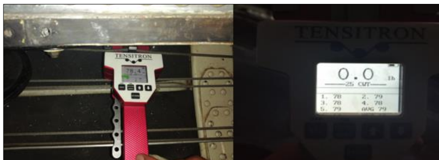
Figura 68 Verificación de la tensión de cables del elevador
