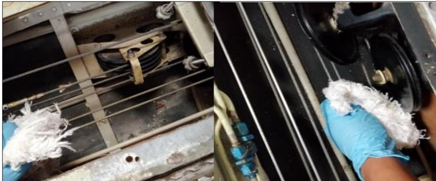
Figura 66 Limpieza de cables del elevador
