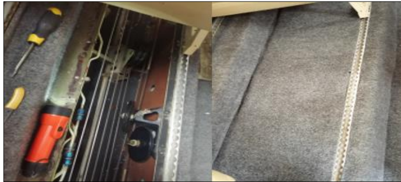
Figura 72 Cierre de paneles de acceso del elevador
