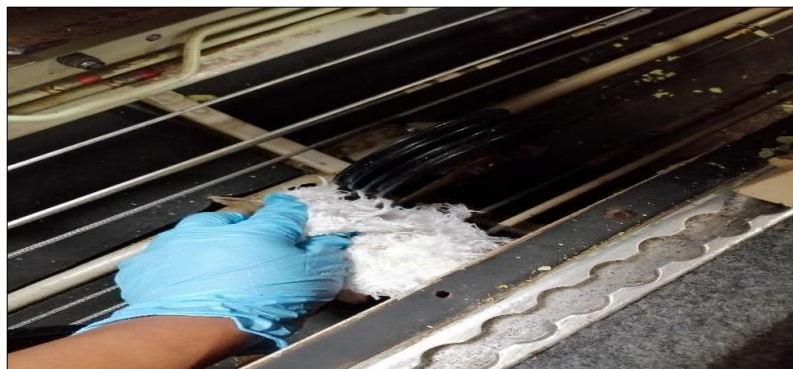
Figura 71 Limpieza del exceso de grasa del elevador
