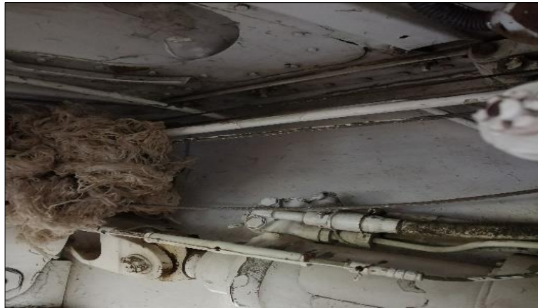
Figura 42 Limpieza del exceso de grasa del alerón
