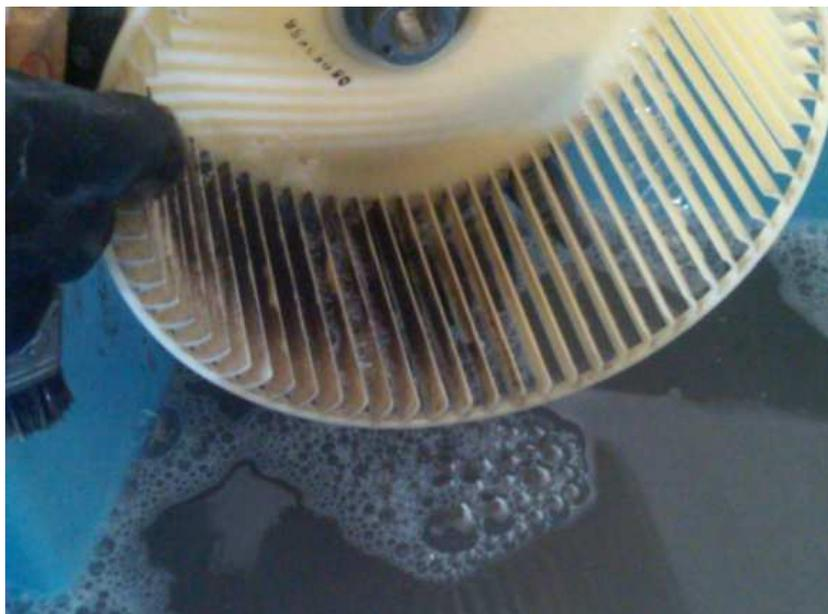
**Figura 3.18:** Lavado de los componentes
