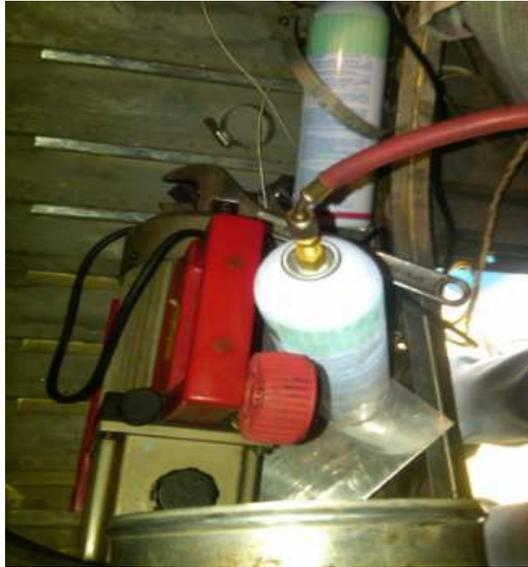
**Figura 3.36:** Conexión de la botella de freón a la bomba de carga
