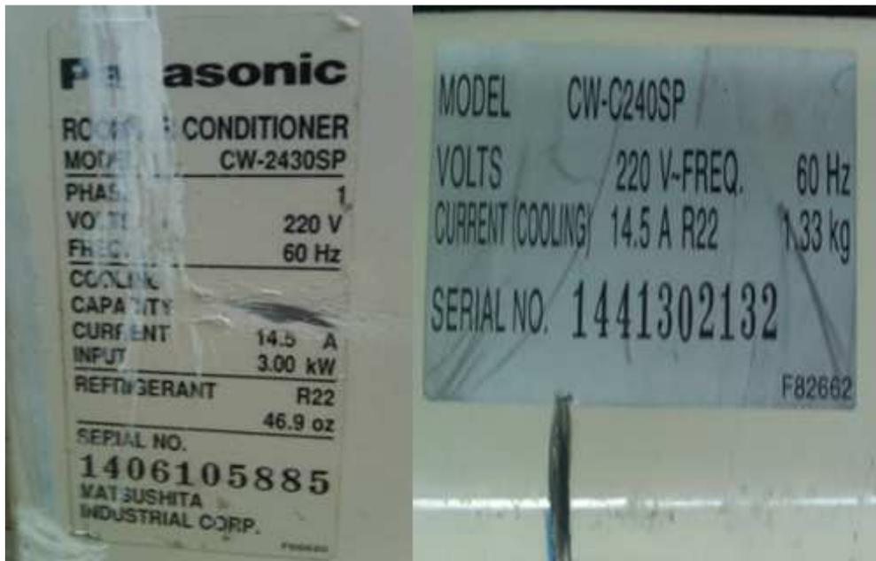
**Figura 3.11:** Especificaciones técnicas del aire acondicionado
