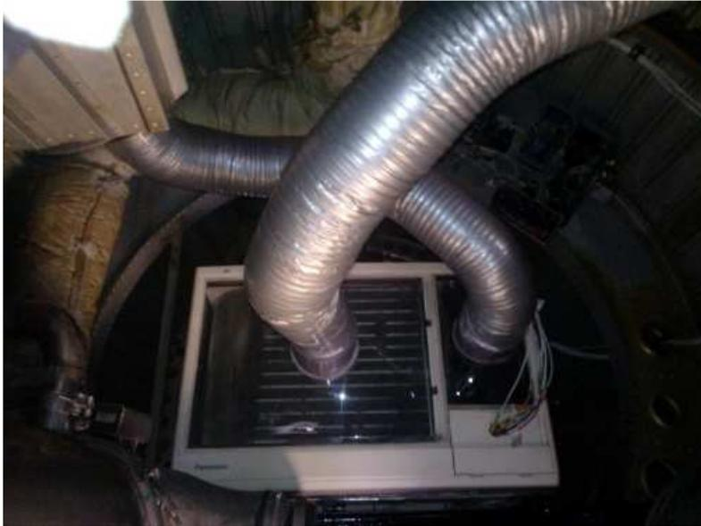
**Figura 3.47:** Unión de cañerías al sistema
