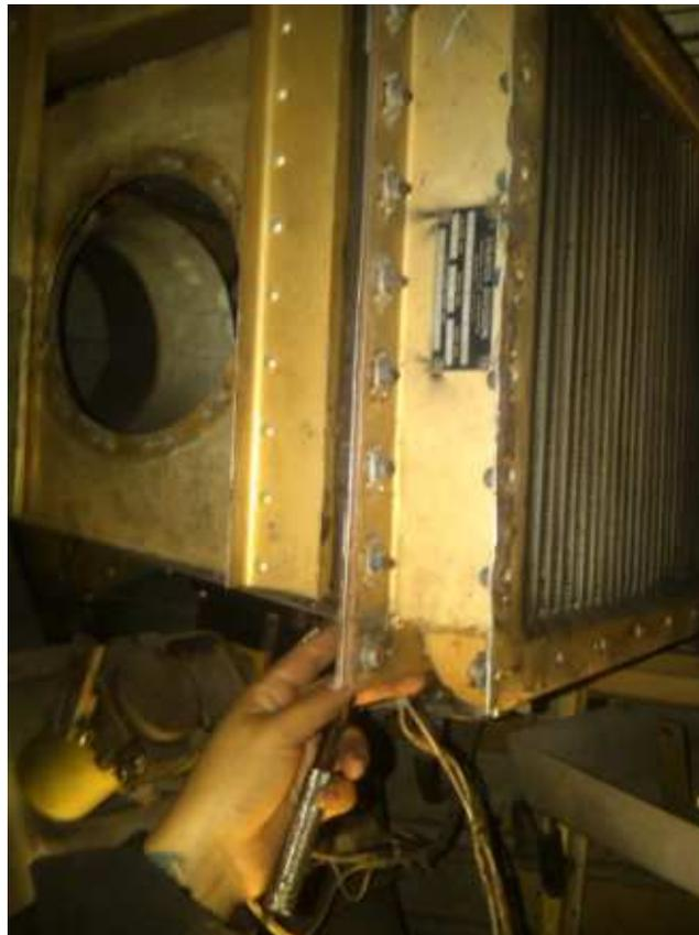
**Figura 3.40:** Remoción del evaporador obsoleto
