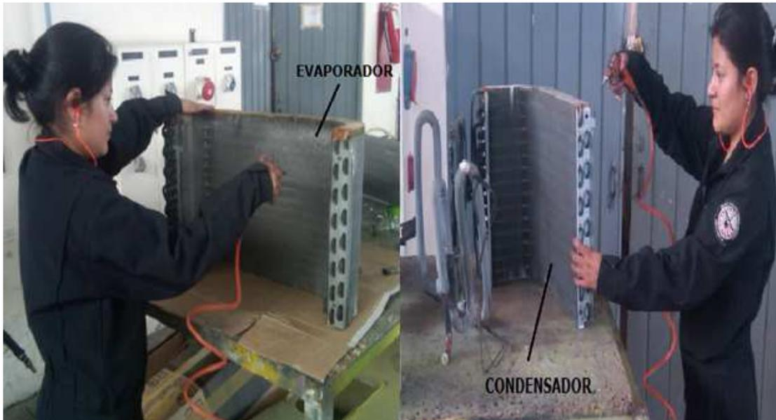
**Figura 3.20:** Sopleteado del evaporador y condensador
