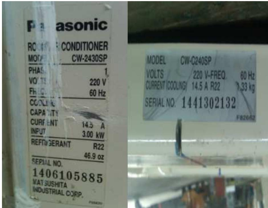
**Figura 3.35:** Valores del sistema de aire acondicionado
