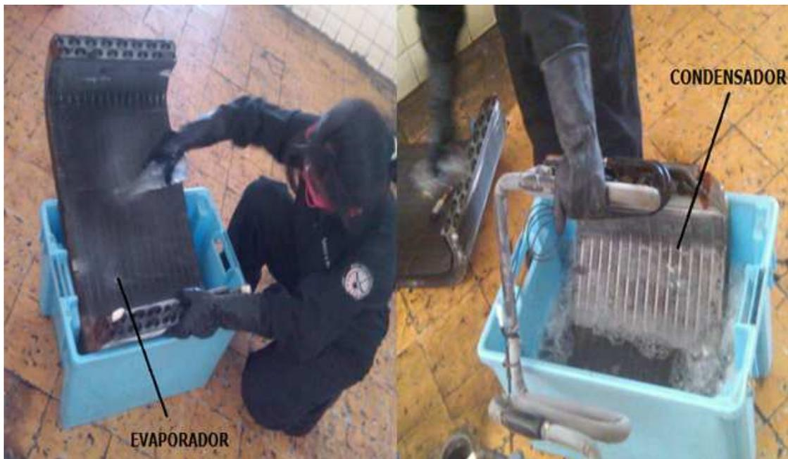
**Figura 3.21:** Lavado del evaporador y condensador
