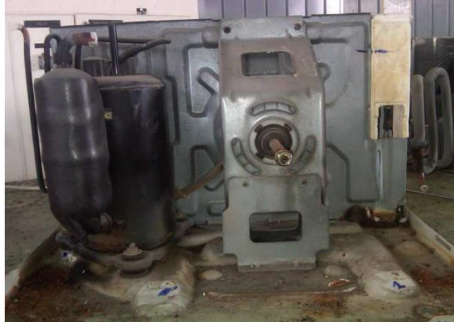
**Figura 3.14:** Remoción del motor compresor
