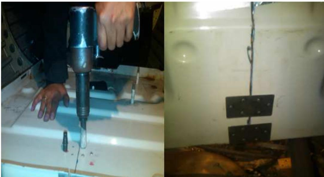
**Figura 3.22:** Remachado de la base del aire acondicionado
