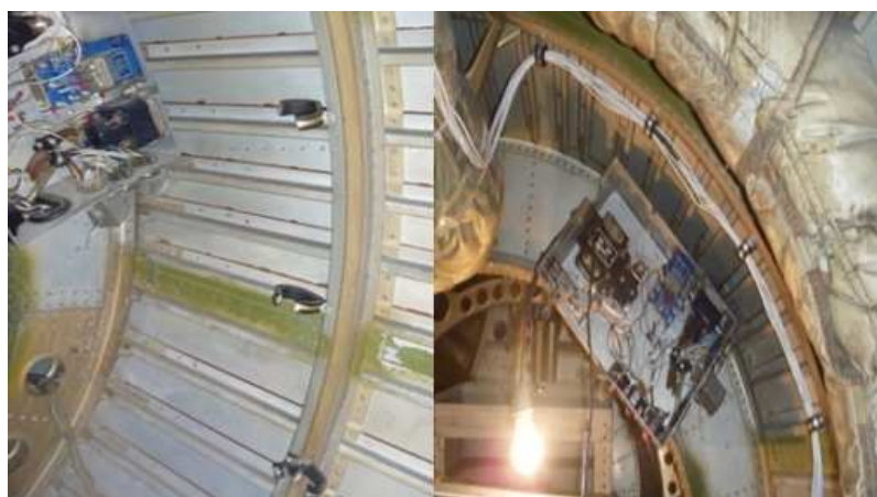
Figura 3.14: Uniones Enrutamiento de cable con abrazaderas
