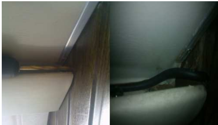
Figura 3.17: Enrutamiento del cable de alimentación eléctrica
