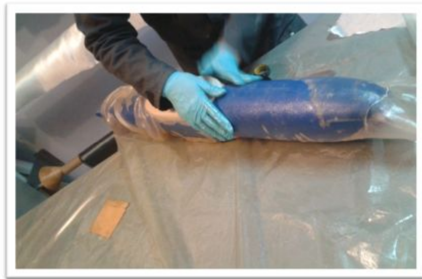
Figura 3.15: Colocación de Fibra de vidrio/ Resina
