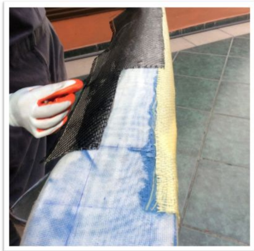
Figura 3.27. Laminado Carbono en Bordes de Ataque
