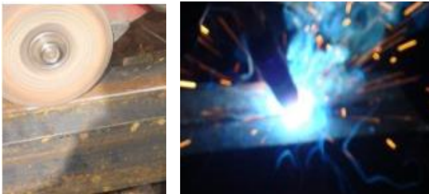
Figura 4.25. Biselado y soldadura GMAW
