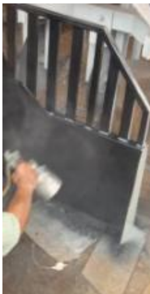
Figura 4.36. Lijado y pintado de toda la estructura
