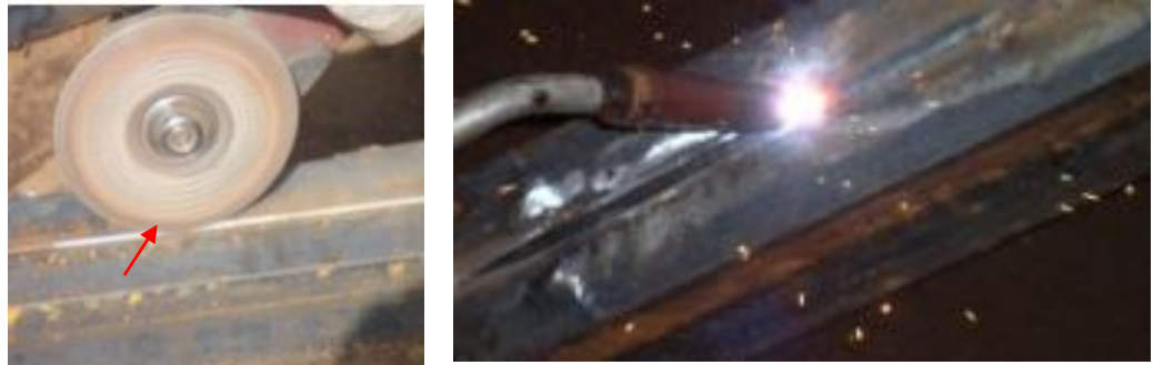
Figura 4.22. Bisel y proceso de soldadura GMAW
