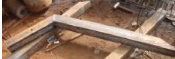
Figura 4.26. Verificación de soldadura GMAW
