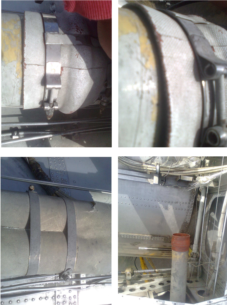
Figura 3.12: Desmontaje de la toma de aire
