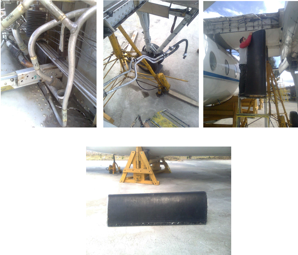
Figura 3.11: Desmontaje del borde de ataque del ala central
