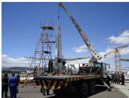
Figura 3.4: Equipo y herramientas utilizadas en el desmontaje
