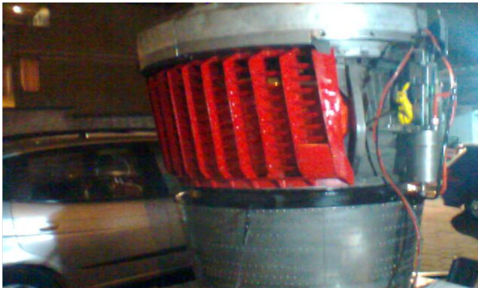
Figura 3.25. Instalación de las cascade vanes
