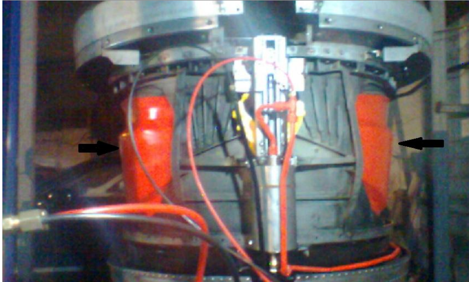
Figura 3.24. Instalación de las clamshell doors
