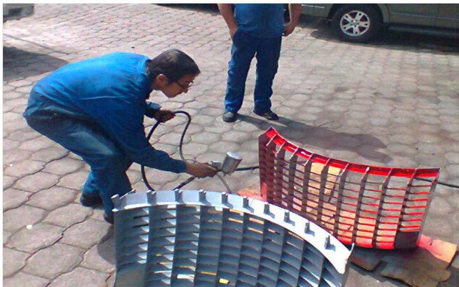
Figura 3.18. Acabado, limpieza y pintura
