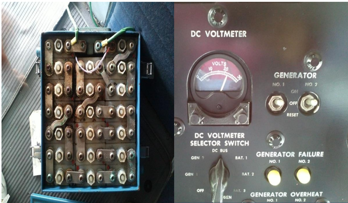
Figura 3.22: Voltaje de la batería.
