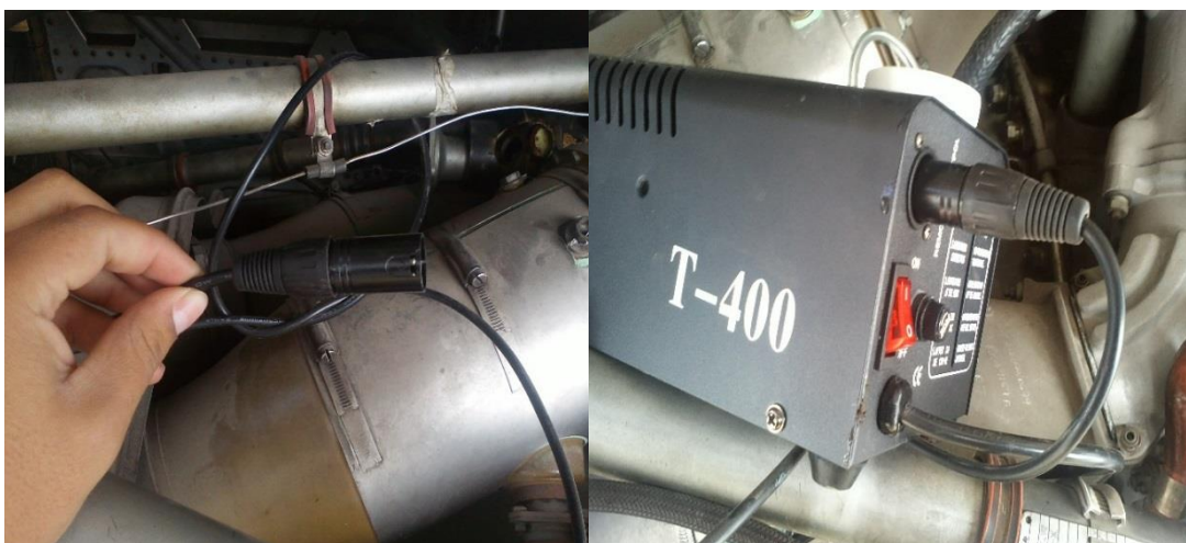
Figura 3.21: Instalación de la máquina de humo
