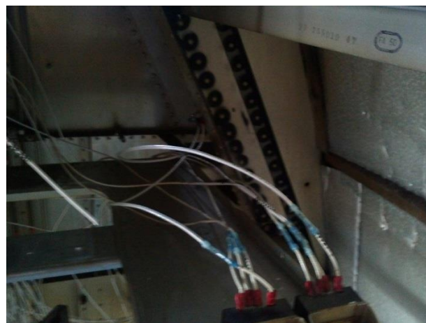
Figura 3.9: Unión de cables mediante espaguetis.
