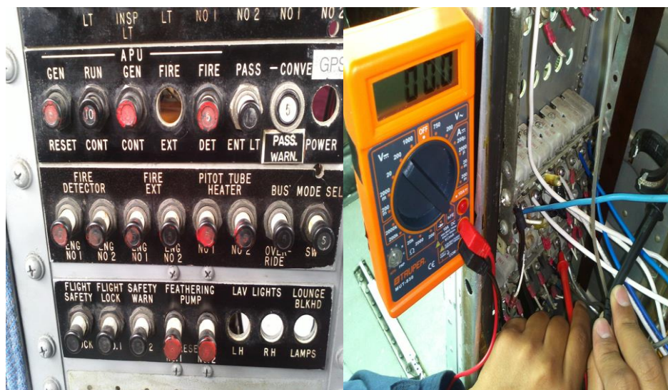
Figura 3.24: Verificación de los circuit breake abiertas:
