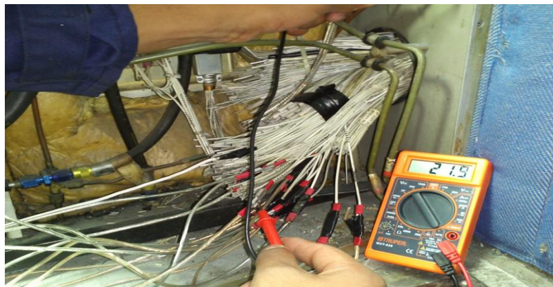
Figura 3.26: Verificación de continuidad eléctrica de los cables en cabina
