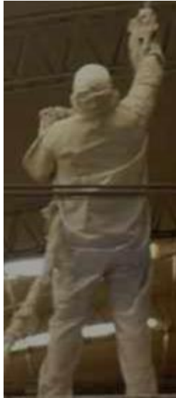
Figura 3.44: Pando fondo con el primer y pintado
