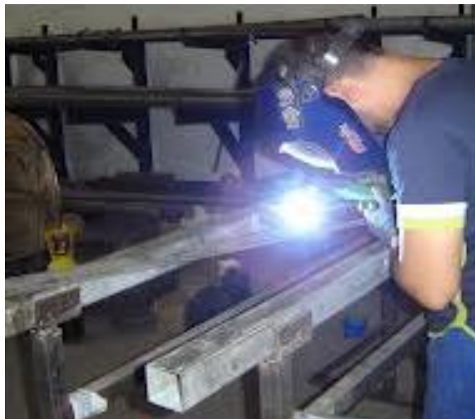
Figura3.28: Soldando los tubos de la estructura
