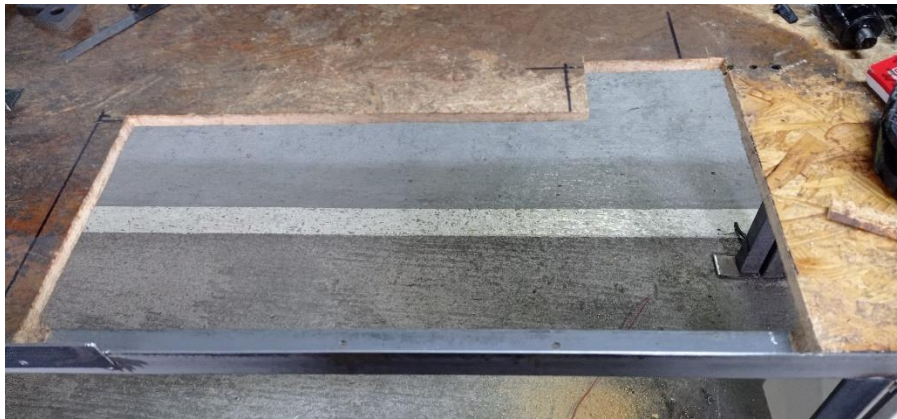
Corte de la mesa para instalación del sistema de transporte
