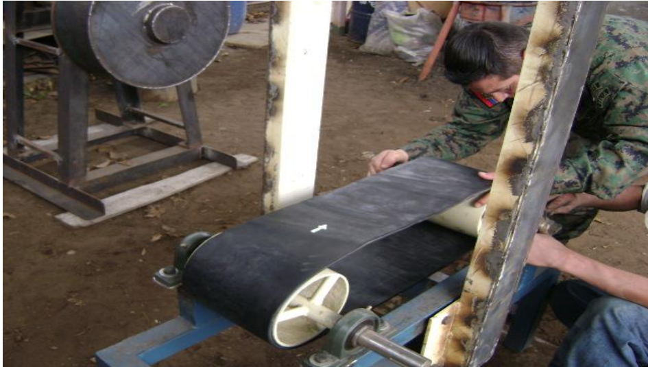
Fig 5.10 Montaje de la banda en el sistema de rodadura
