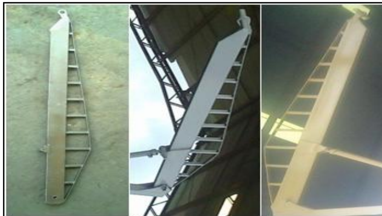
Figura 3.12. Pintura de la viga
