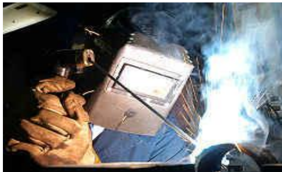
Figura 2. 29. Soldadura de arco
