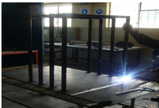
Figura 3. 9. Soldadura a la plancha de acero
