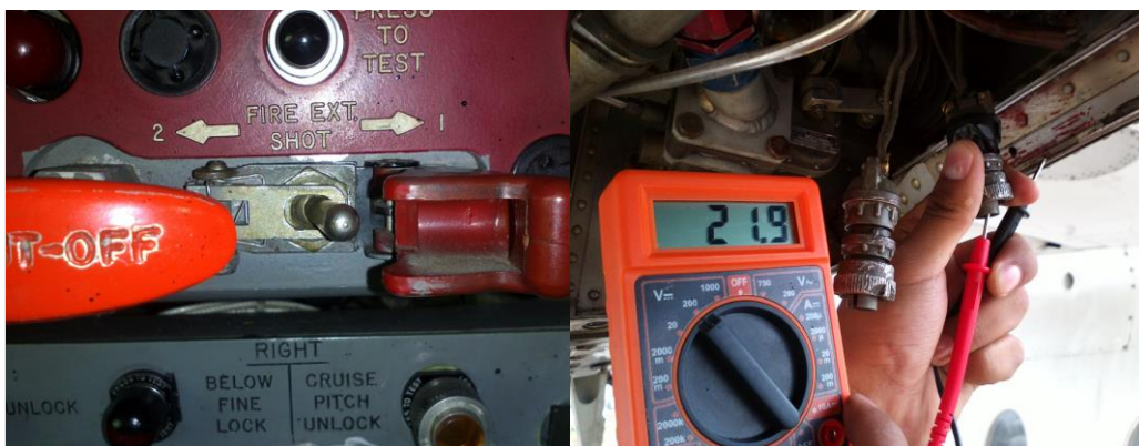
Figura 3.26: Continuidad eléctrica de los plugs extintores N°1
