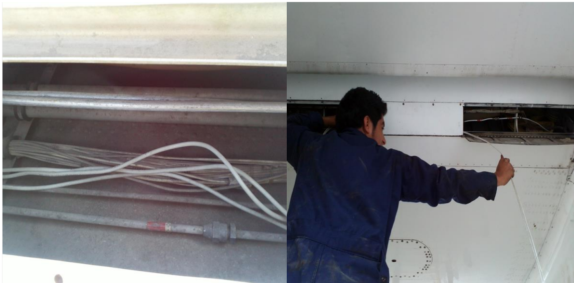
Figura 3.15: Compartimientos y bahías secas por donde se envió los cables
