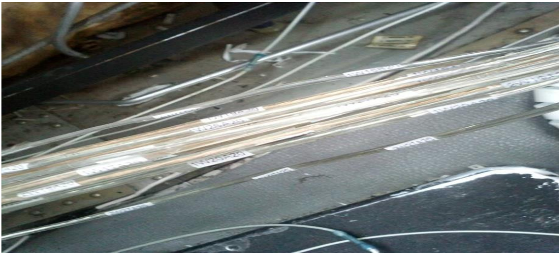
Figura 3.13: Marcación e identificación del cable eléctrico
