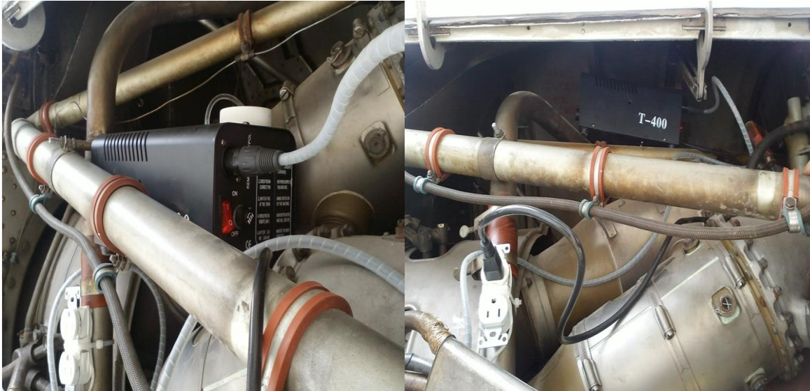
Figura 3.20: Instalación de la máquina de humo
