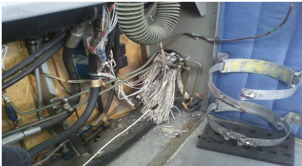
Figura 3.6: Cables cortados de la cabina parte trasera
