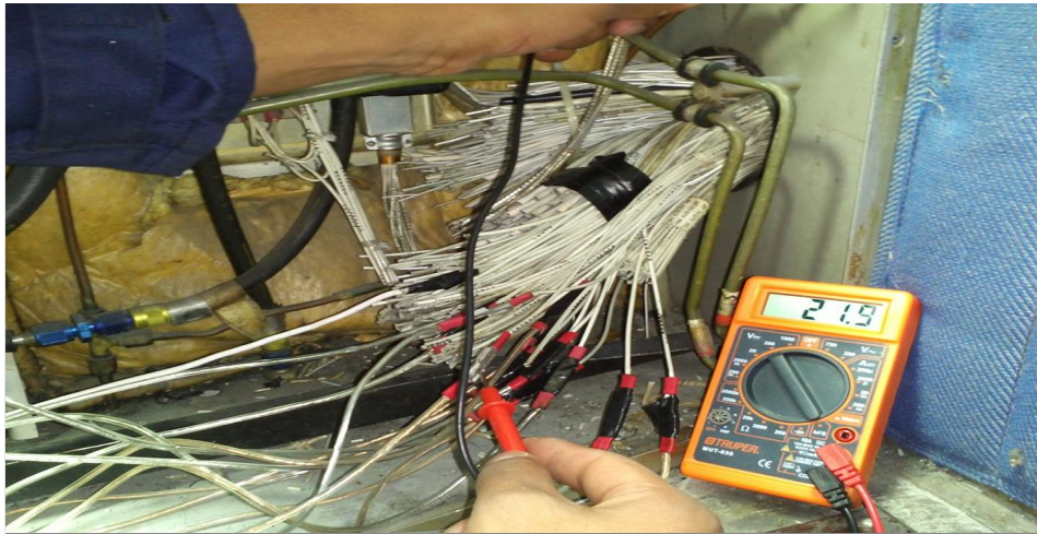
Figura 3.25: Verificación de continuidad eléctrica de los cables en cabina
