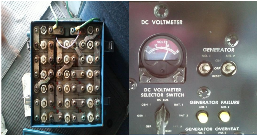
Figura 3.21: Voltaje de la batería
