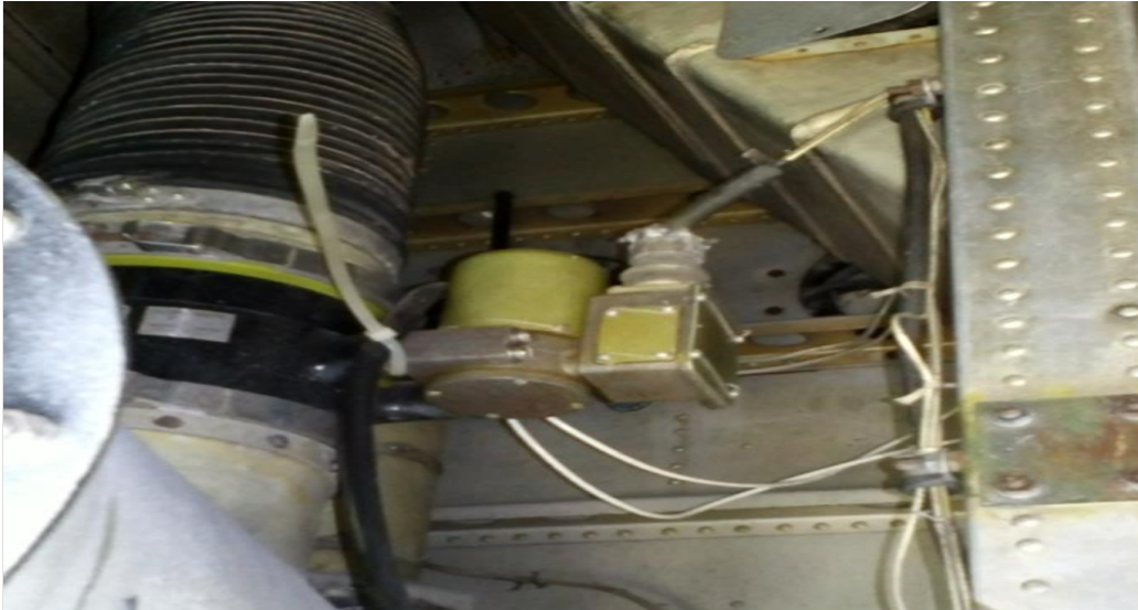
Figura 3.16: Empalme en la fuente de poder de 110 V ac.
