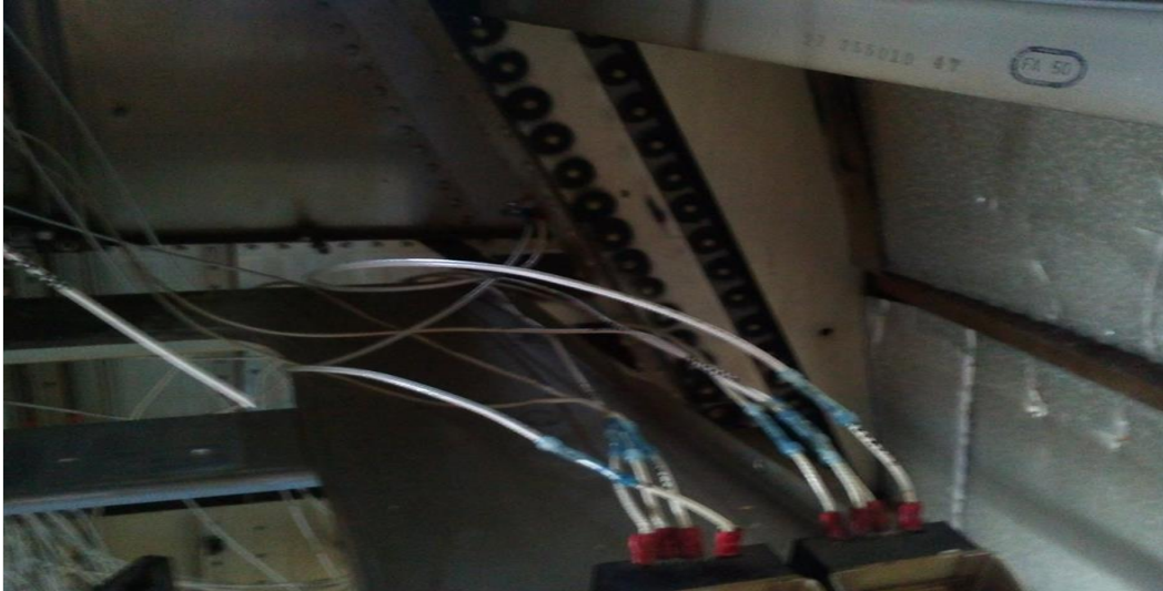
Figura 3.7: Unión de cables mediante espaguetis.
