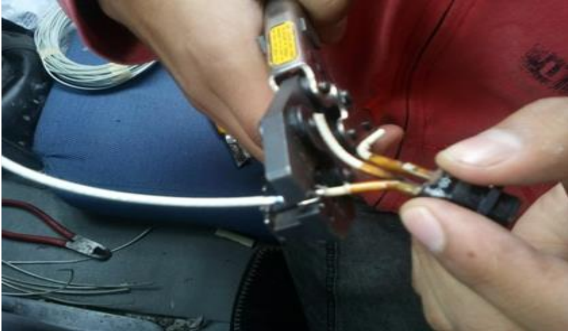
Figura 3.3: Remachadora de uniones frías
