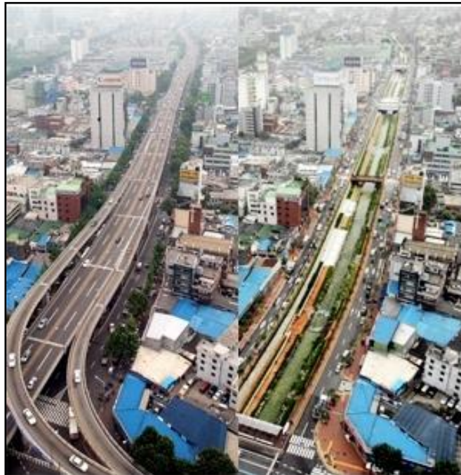
Figura 4.27.- Regeneración urbana, recuperación del canal de Cheoggyecheon en Corea del Sur.
