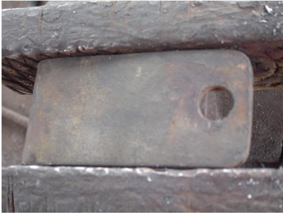
Figura 4-4 Construcción de las orejas de sujeción
