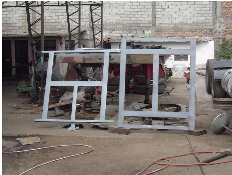
Figura 4-18 Fondeado de la estructura
