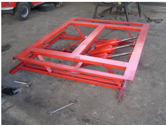
Pintado de la estructura
