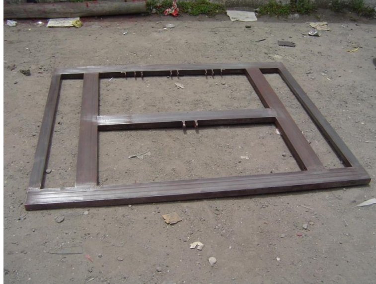
Figura 4-17 Lijado y pulido de la estructura soporte
