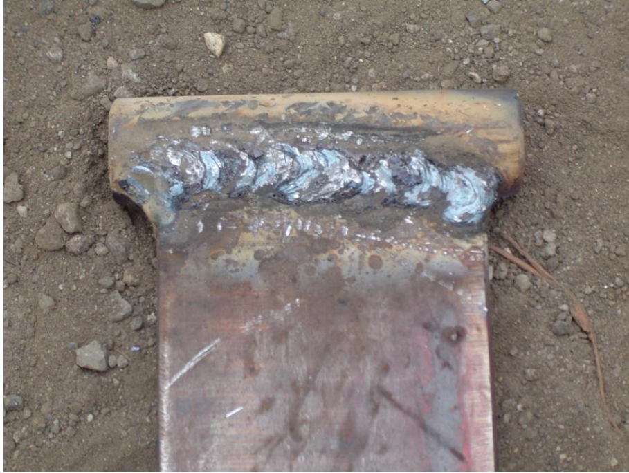
Figura 4-11 Soldadura de las guías
