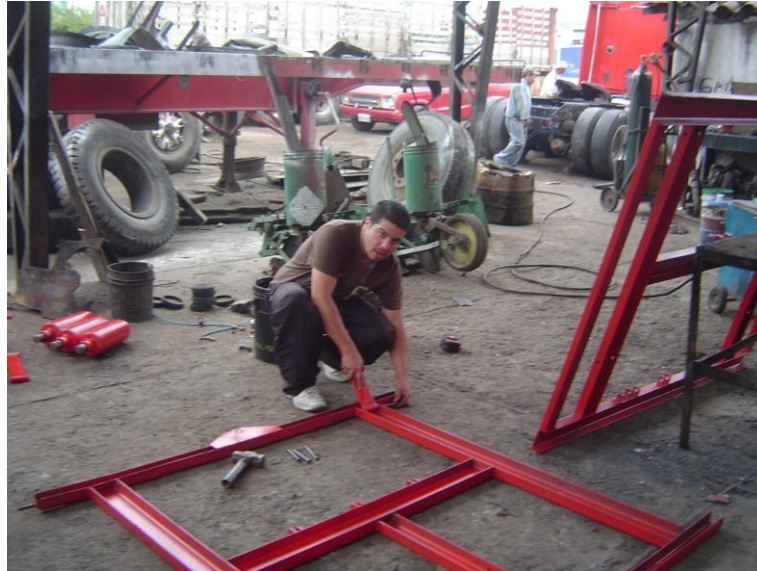
Figura 4-23 Colocación de guías y pasadores
