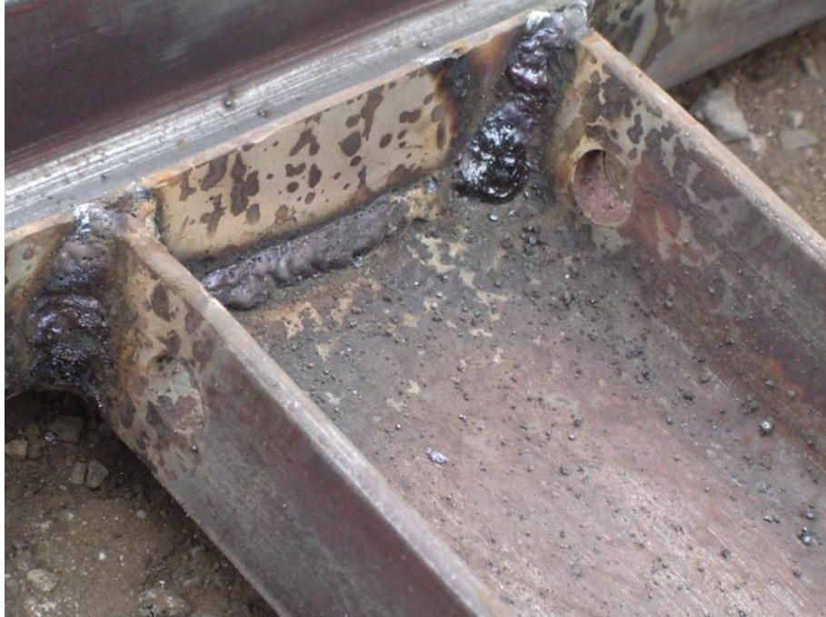
Figura 4-8 Acabado de la Soldadura del Bastidor
