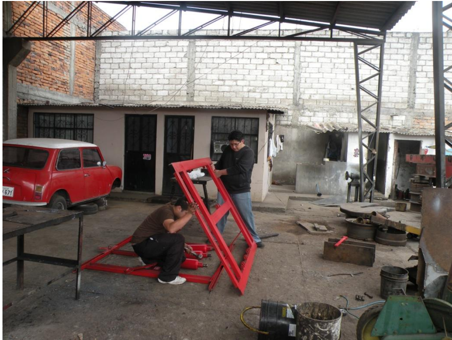
Figura 4-25 Montaje del la estructura soporte
