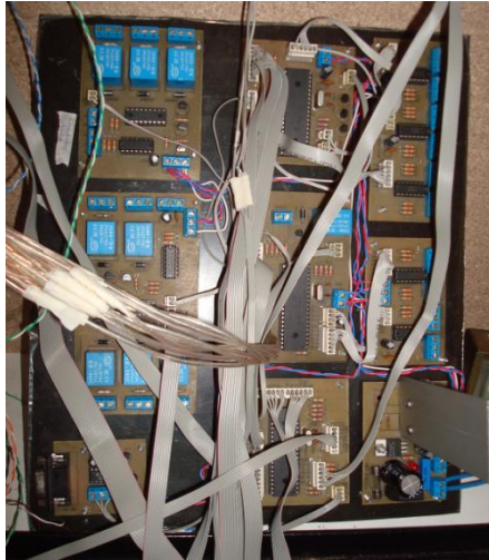
Figura 4.17 Instalación del circuito eléctrico.
