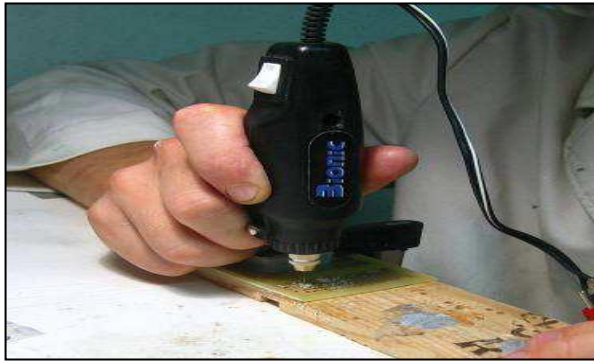
Figura 4.8.- Perforación de la placa
