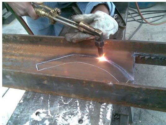
Figura 37. Corte de placa soporte alternador.
