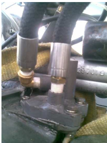
Figura 39. Instalación de cañerías
