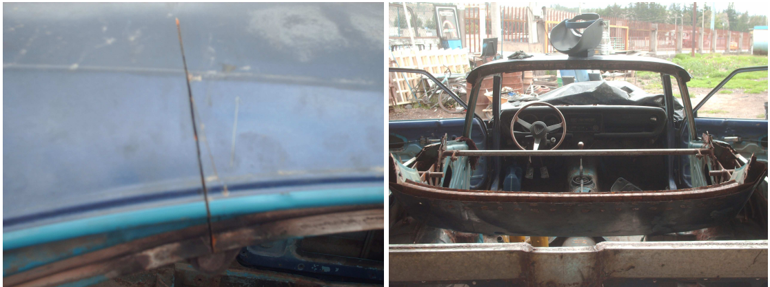
Figura 4.8. Corte del techo y giro de prueba.
