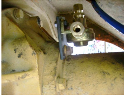
Figura 4.30 Colocación de la válvula 800 delantera
