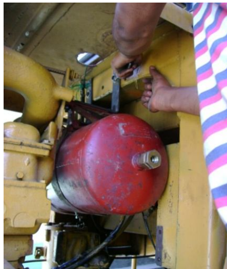
Figura 4.27 Ubicación del tanque
