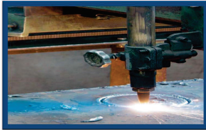
Figura 2.13 Corte en la plancha A36
