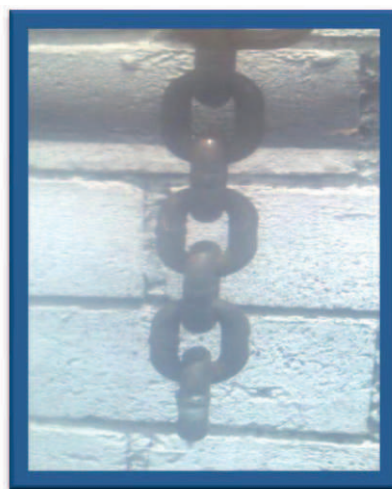
Figura: 3.13 Cadena soldada a la plancha de acero A36
