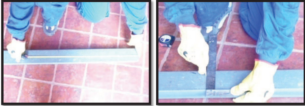
Figura 3.22: Medición del material Fuente: Construcción
