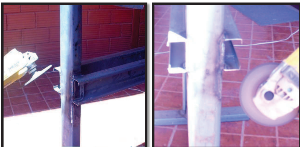
Figura 3.25: Esmerilado Fuente: Construcción
