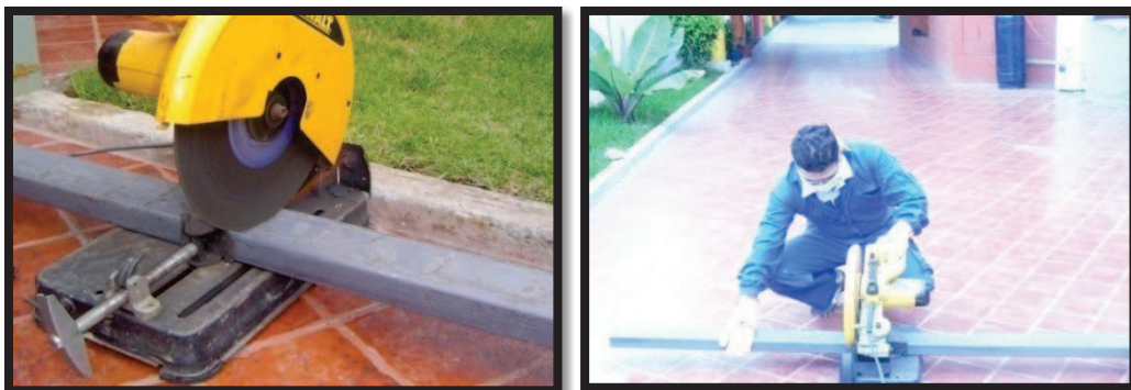
Figura 3.23: Corte del material Fuente: Construcción
