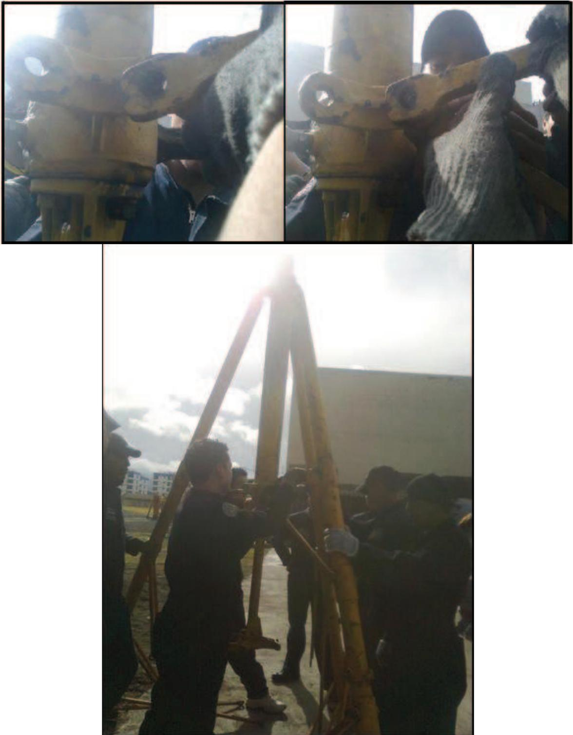
**Figura 3.10:** Colocación de pernos
