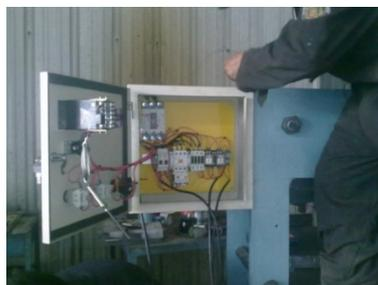
**Figura 5.24 Montaje del sistema eléctrico**
