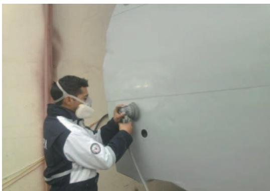
**Figura N° 66.**-Proceso de pulido de la cabina del avión Boeing 707.
