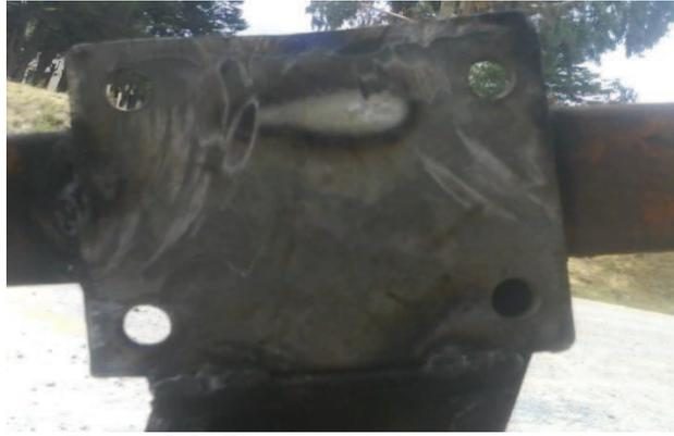
**Figura 3.9:** Placas soldadas a la estructura
