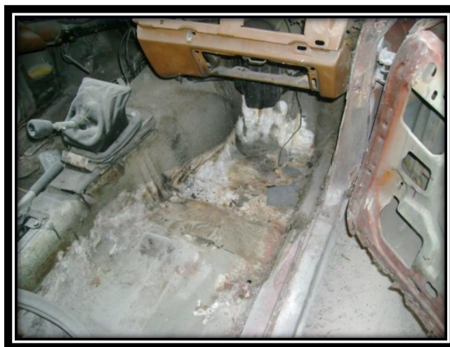
Figura 4.5.- Extracción de Piso Deteriorado.
