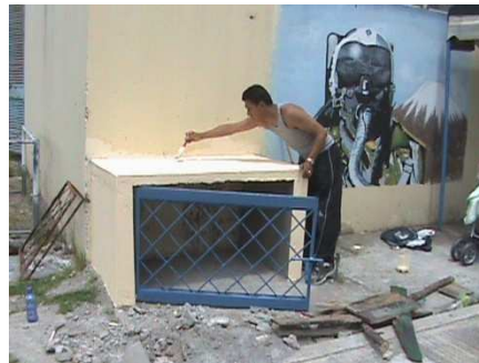
Fig. 3.29 Pintado de la cubierta y de la puerta de seguridad
