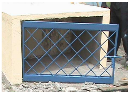
Fig. 3.16 Puerta metálica de seguridad
