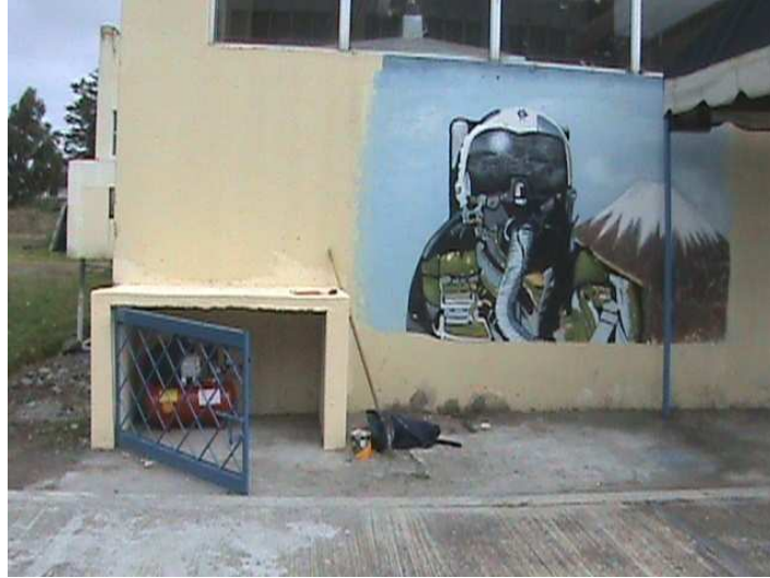
Ubicación y estado actual del compresor y su cubierta
