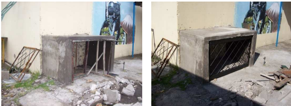
Fig. 3.17 Construcción de la cubierta del compresor
