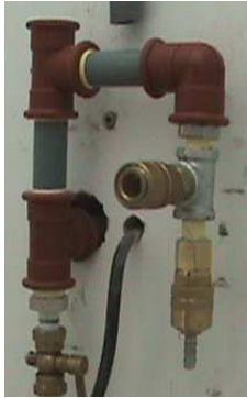
Fig. 3.25 Colocación de conectores rápidos
