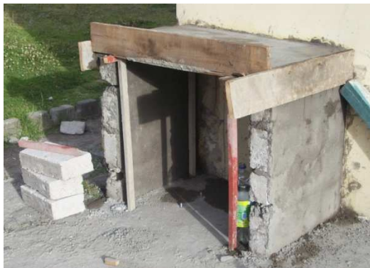
Fig. 3.5 Construcción de la cubierta para el compresor
