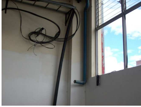
Fig. 2.1. Tubo del antiguo sistema neumático y cables para electricidad
