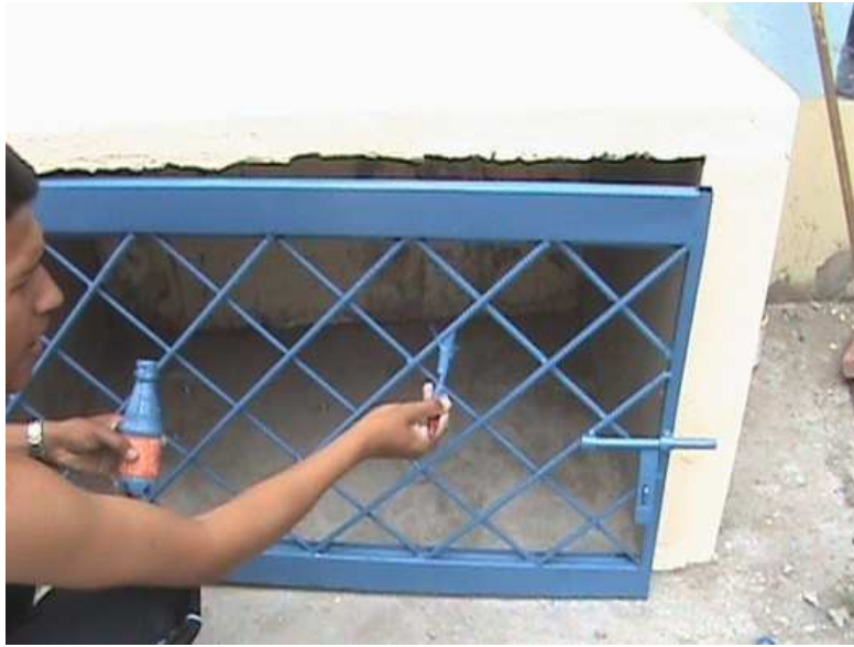
Pintado de la puerta de seguridad de la cubierta del compresor
