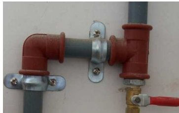
Fig. 3.26 Abrazaderas que sujetan la red
