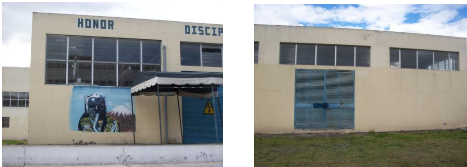
Fig. 3.1 Vista frontal y entrada al bloque 41 del ITSA
