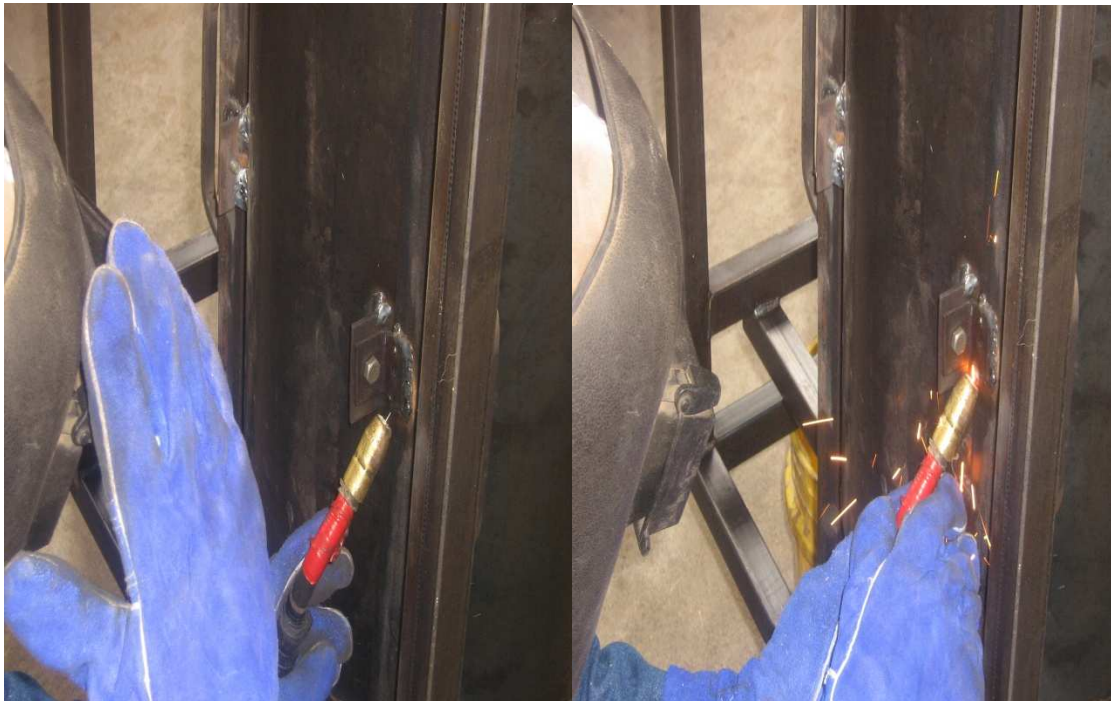
Fig.6 Soldando la platina al depósito hidráulico, para su fijación Realizado por: David Díaz Investigación: De campo
