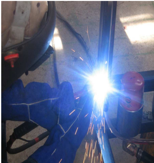
Fig.9 Soldando la platina para fijación del tubo para la indicación del nivel hidráulico del depósito Realizado por: David Díaz Investigación: De campo
