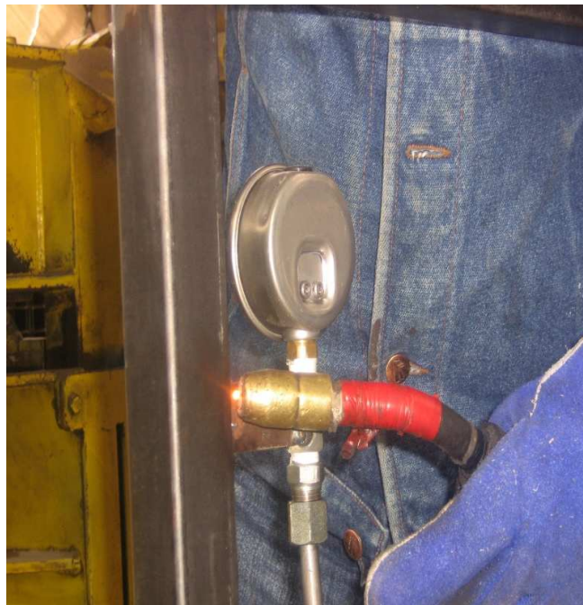
Fig.8 Soldando la platina para la fijación del manómetro de presión Realizado por: David Díaz Investigación: De campo
