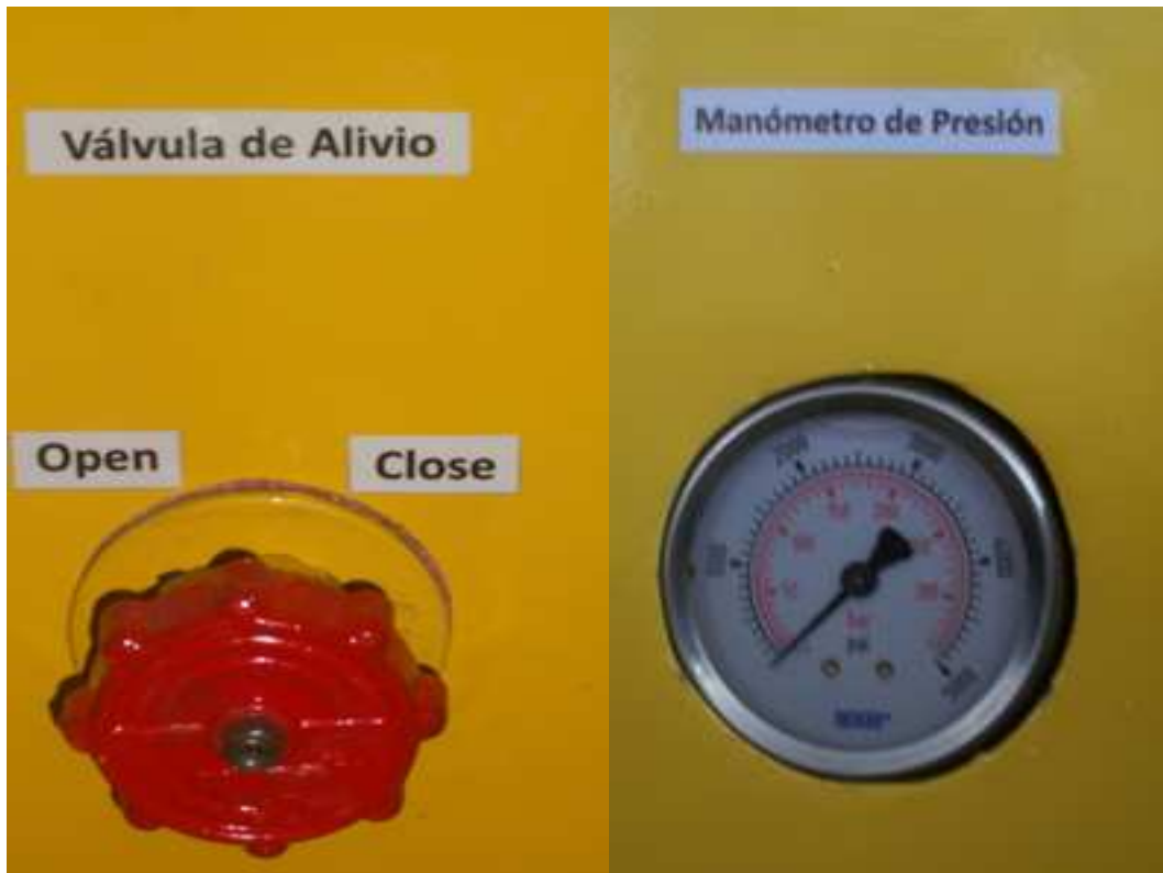
Fig.5 Verificación de la válvula de alivio y el manómetro de presión del Banco Hidráulico
