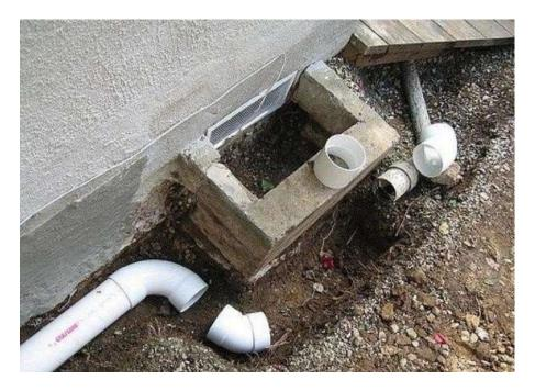
Nota. La imagen muestra un ejemplo de la estructura de un desagüe para evitar la acumulación del líquido desinfectante. Tomado de Drenaje Azul 2019.
