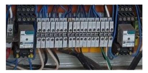
Nota. La imagen representa la utilización de las borneras para la conexión de los dispositivos.
