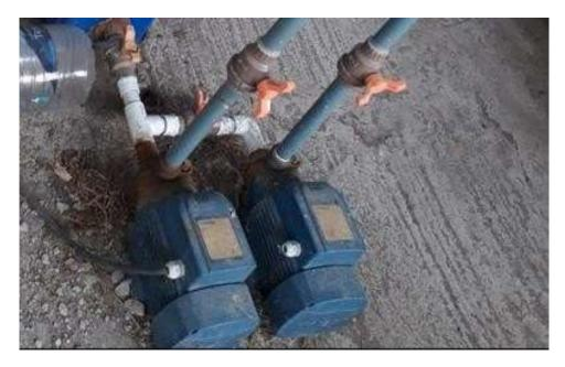
Nota. La imagen representa cómo deberían ir instaladas las tuberías hacia el depósito y hacia las bombas.
