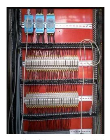
Nota. La imagen representa los conductores que se utilizarán en el tablero de control para el proceso de desinfección. Tomado de INNAC.A 2013.
