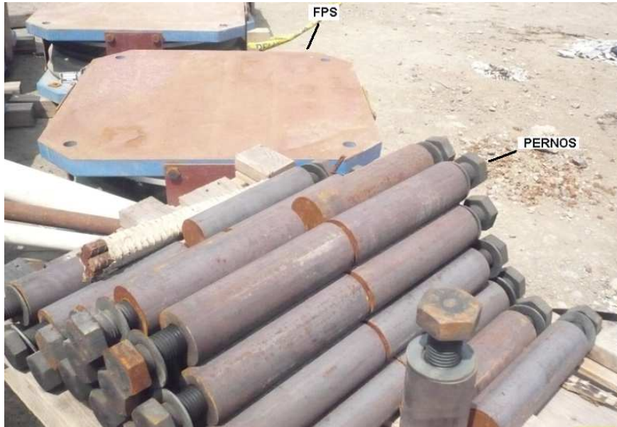
Aisladores FPS tipo Triple Péndulo utilizados en la construcción de 3 Puentes en la Provincia de Esmeraldas en Ecuador.
