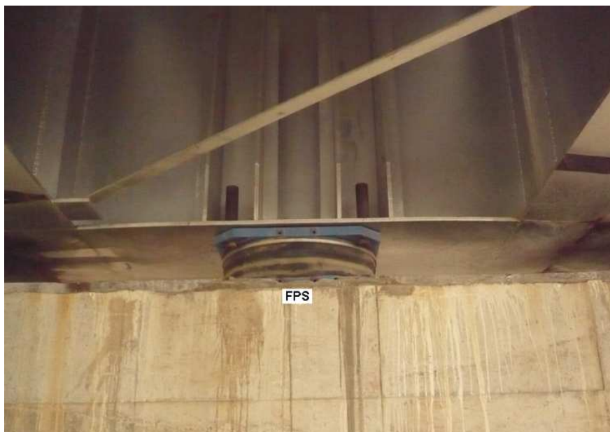
Aisladores FPS tipo Triple Péndulo utilizados en la construcción de 3 Puentes en la Provincia de Esmeraldas en Ecuador.
