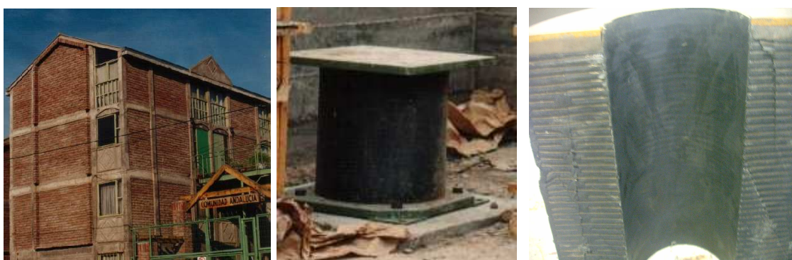
Figura 1.13 Bloque de la Comunidad Andalucía construido con aisladores elastoméricos.
