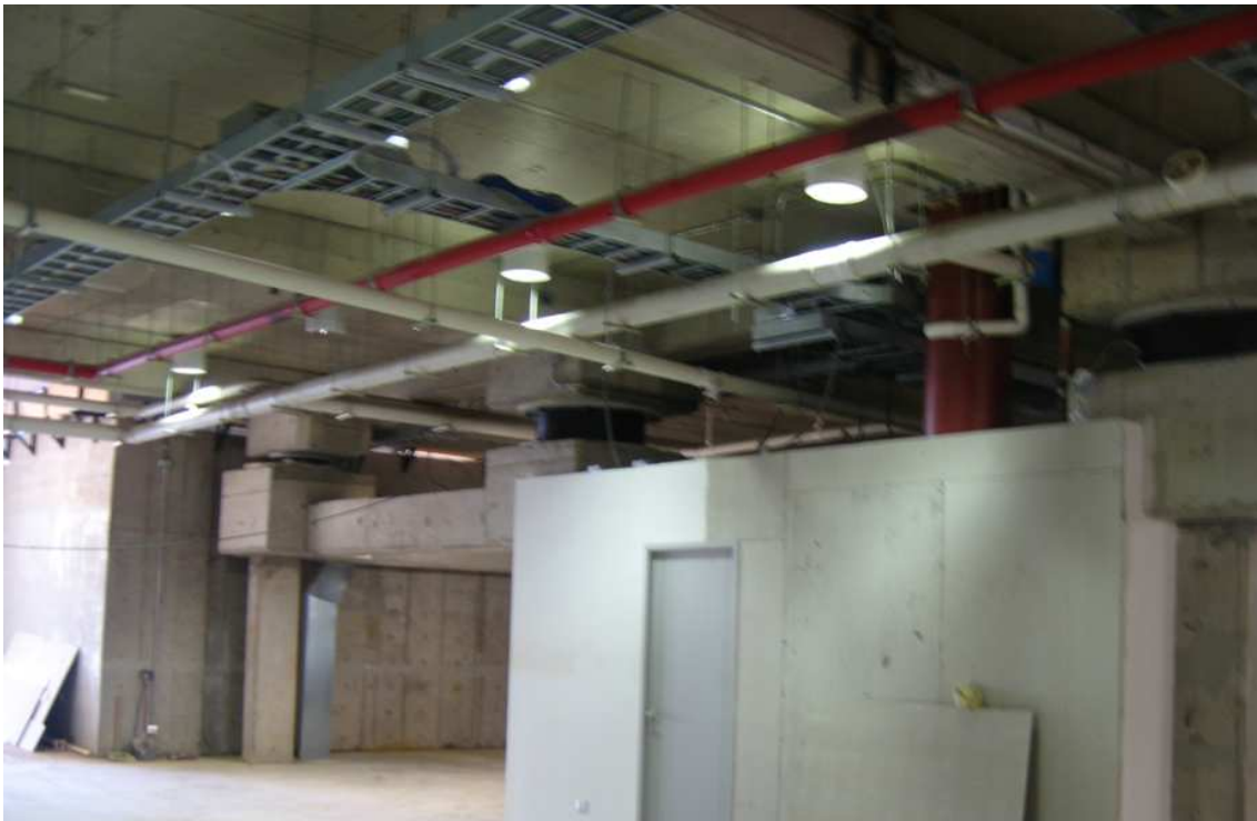
Edificio con aisladores elastoméricos, sobre las columnas de la planta baja, en un edificio de Viña del Mar que se comportó muy bien en el Mega Sismo de Chile de 2010.
