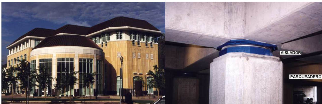
Figura 6.1 Edificio, Hayward City Hall, con aisladores FPS.
