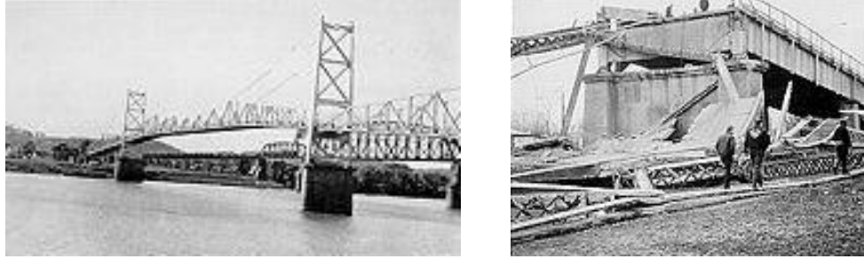
Figura 3.2 Puente Silver (Silver Bridge) antes y después del colapso
