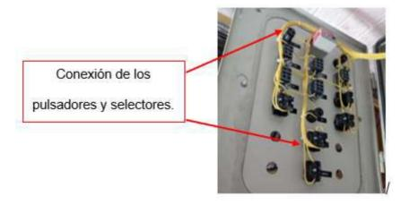
*Nota.* Todos los pulsadores y accionadores fueron colocados en la tapa superior del tablero de control, posterior a ello se utilizó bridas para dejar los cables recogidos.
