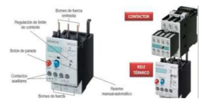
*Nota.* En la parte superior se puede aprecia un relé térmico con sus partes, estos son elementos que poseen características singulares tales como:
