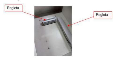
*Nota.* Para que dentro del tablero no exista un dersorden se realizó un peinado de los cables y se los colocó dentro de las regletas para el cableado.
