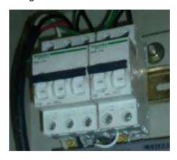
Nota. Se aprecia el breaker o disyuntor, cuando existe una corriente eléctrica que sobrepase el valor nominal de este elemento, el automáticamente se abre impidiendo el paso de corriente y protegiendo la máquina o sistema (Ramírez, 2017).
