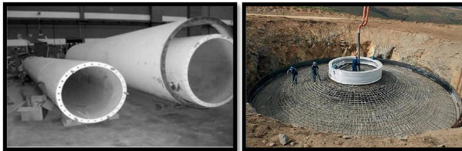
*Nota.* En la figura 6 se muestra la base de hormigón, en donde se ubicará el parante del aerogenerador incluido la estructura base. Tomado de (Carta, Calero Pérez, & Colmenar Santo, 2018).
