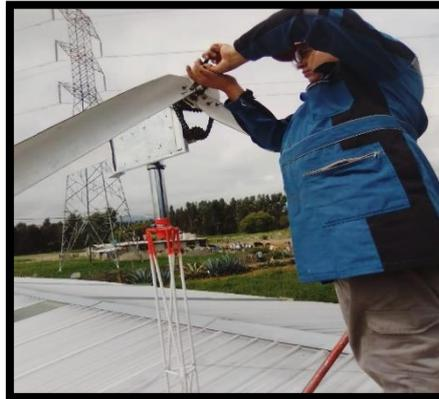
*Nota.* La figura muestra el montaje de las aspas, previo a la realización de pruebas de funcionamiento.
