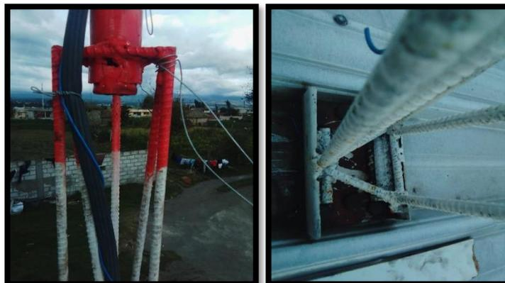
*Nota.* Para sujetar el parante se utilizó 6 tornillos con arandelas de presión para más estabilidad ante el movimiento.
