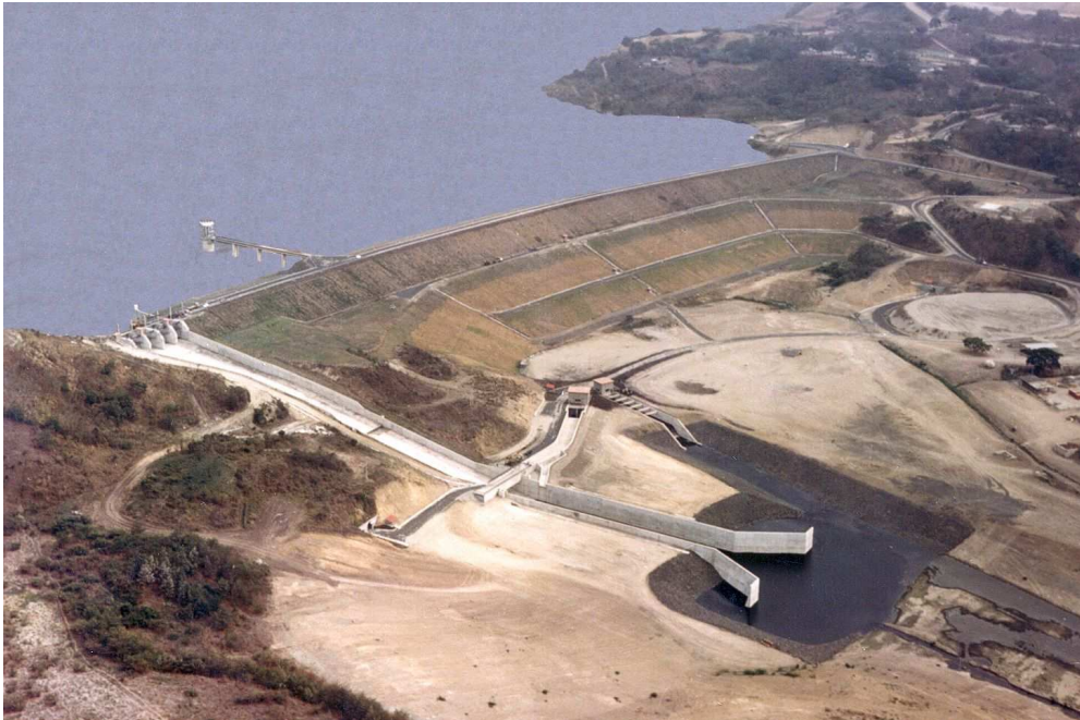
Figura 1 Vista aérea de la Presa la Esperanza.
