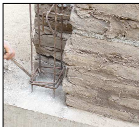
Fig.35. Confinamientos y refuerzo horizontal en el primer piso del módulo de adobe ensayado en mesa vibradora. Una de las conclusiones fue la necesidad de reforzar horizontalmente también al piso 2, para integrar todos los adobes con las columnas.
