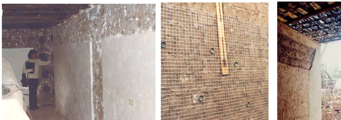
Fig.36. Reforzamiento de casas de adobe con malla electrosoldada en 1998.
