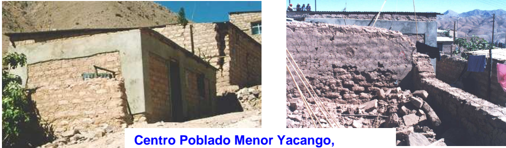
Fig.37. Viviendas reforzadas y no reforzadas en Moquegua después del sismo del 2001.
