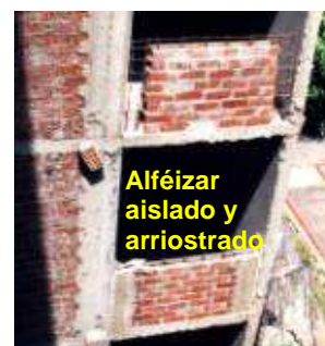
Fig.18. Efectos del alféizar (izq.) y aislamiento (der.).
