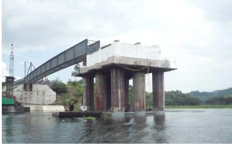
Figura 1 Uno de los apoyos del Puente sobre el río Carrizal.
