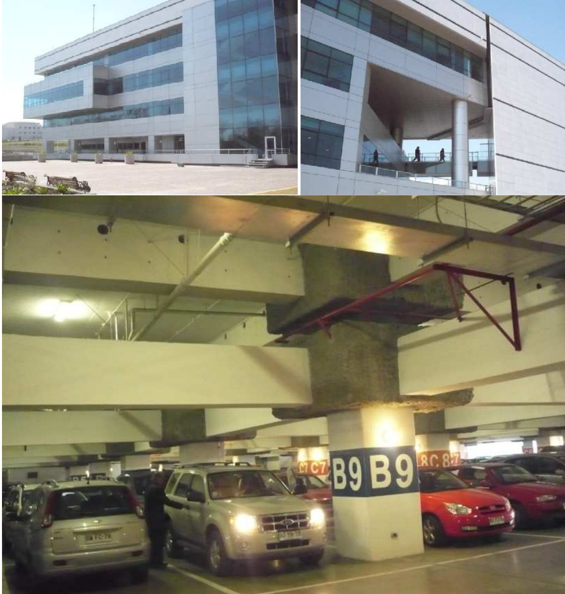
Figura 2 Hospital Militar con aisladores de base elastoméricos.
