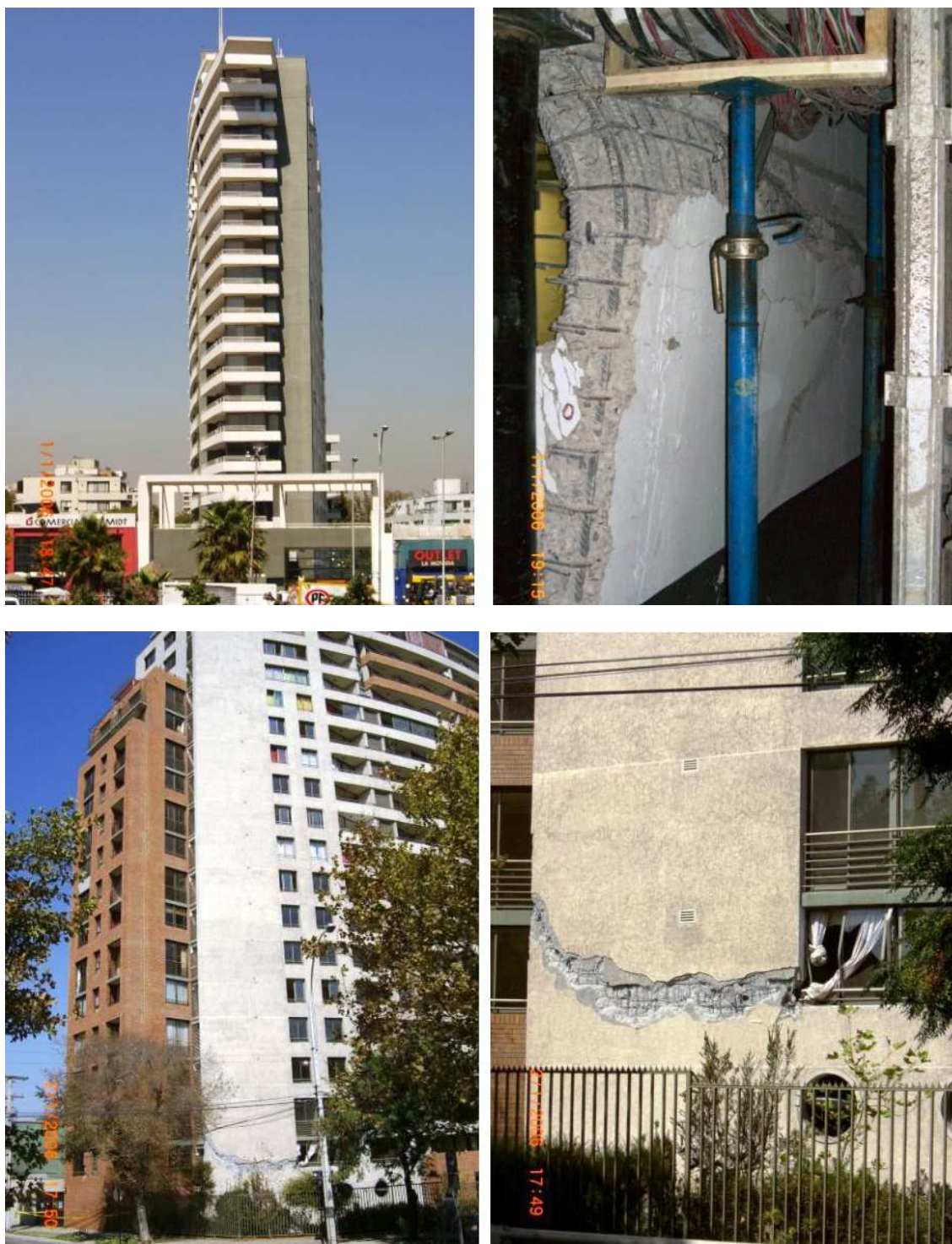
Figura 1 Fallas en edificios con muros de corte durante el sismo de Chile de 2010.
