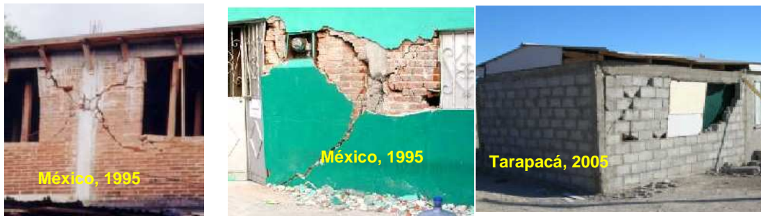
Fig.19. Muros No Confinados.
