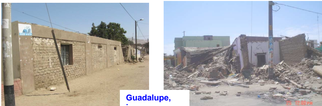
Fig.38. Viviendas reforzadas y no reforzadas en Ica después del sismo del 2007.
