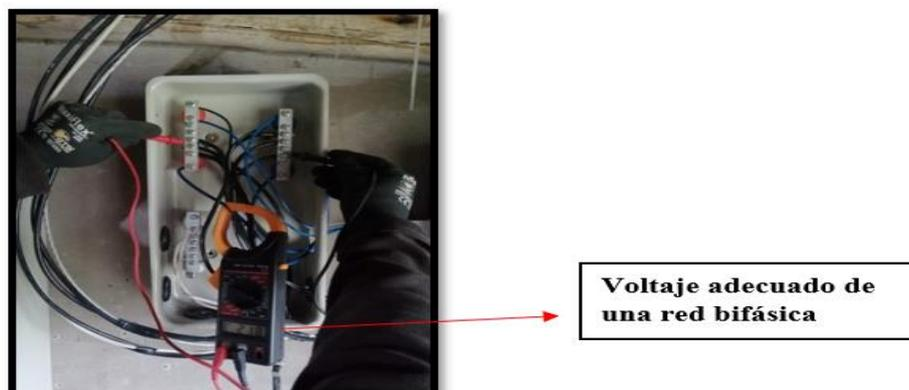
*Nota.* Verificación del voltaje en la caja principal después de cambiar los empalmes de la red bifásica.
