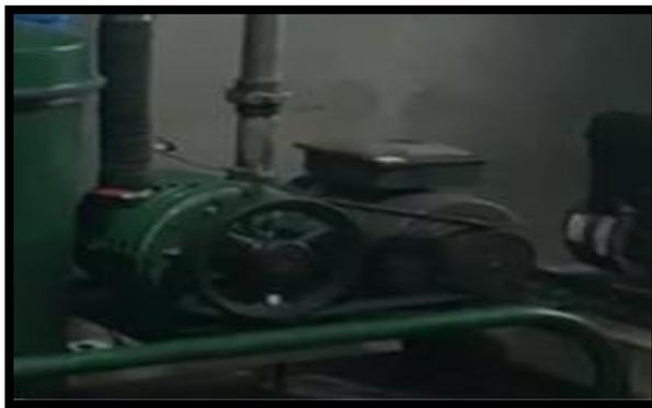
*Nota.* El motor está vinculado a la bomba en vacío mediante poleas para ejercer el movimiento con un fuerte torque haciendo funcionar el mencionado tanque en vacío para el ordeño mecánico.
