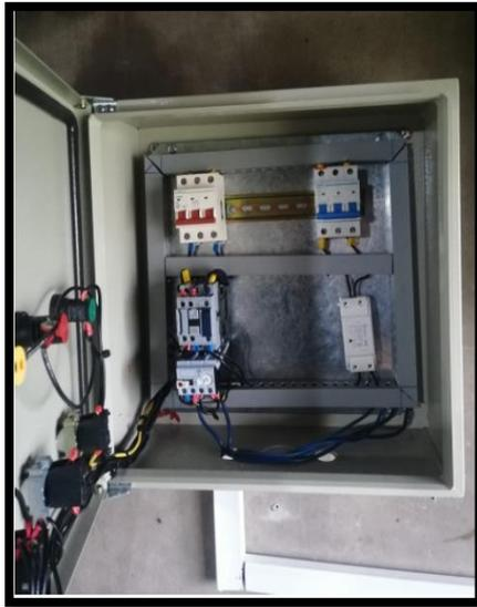
*Nota.* Componentes los cuales se conectarán mediante conductores adecuados a la carga para el encendido y apagado del motor WEG.
