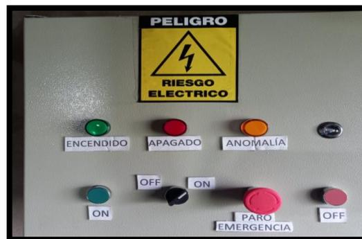
*Nota.* Funcionamiento del motor WEG mediante un selector para la marcha y dos pulsadores para el paro.
