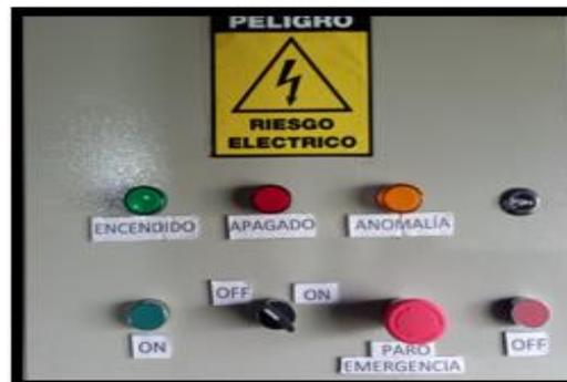
*Nota.* El selector de tres posiciones está diseñado para trabajar en dos maneras diferentes, de forma manual o mediante Wifi por el interruptor inteligente SONOFF R2.
