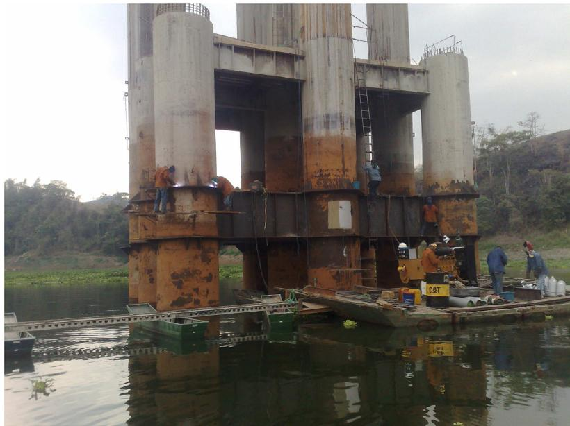
Figura 4 Pilotes y vigas de acero de apoyos centrales.
