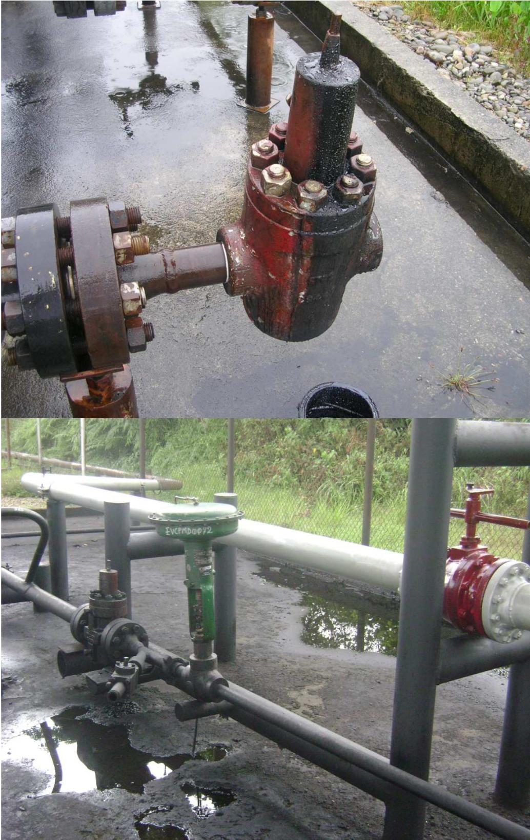
**Figura 3.7 Foto de válvulas en malas condiciones**
