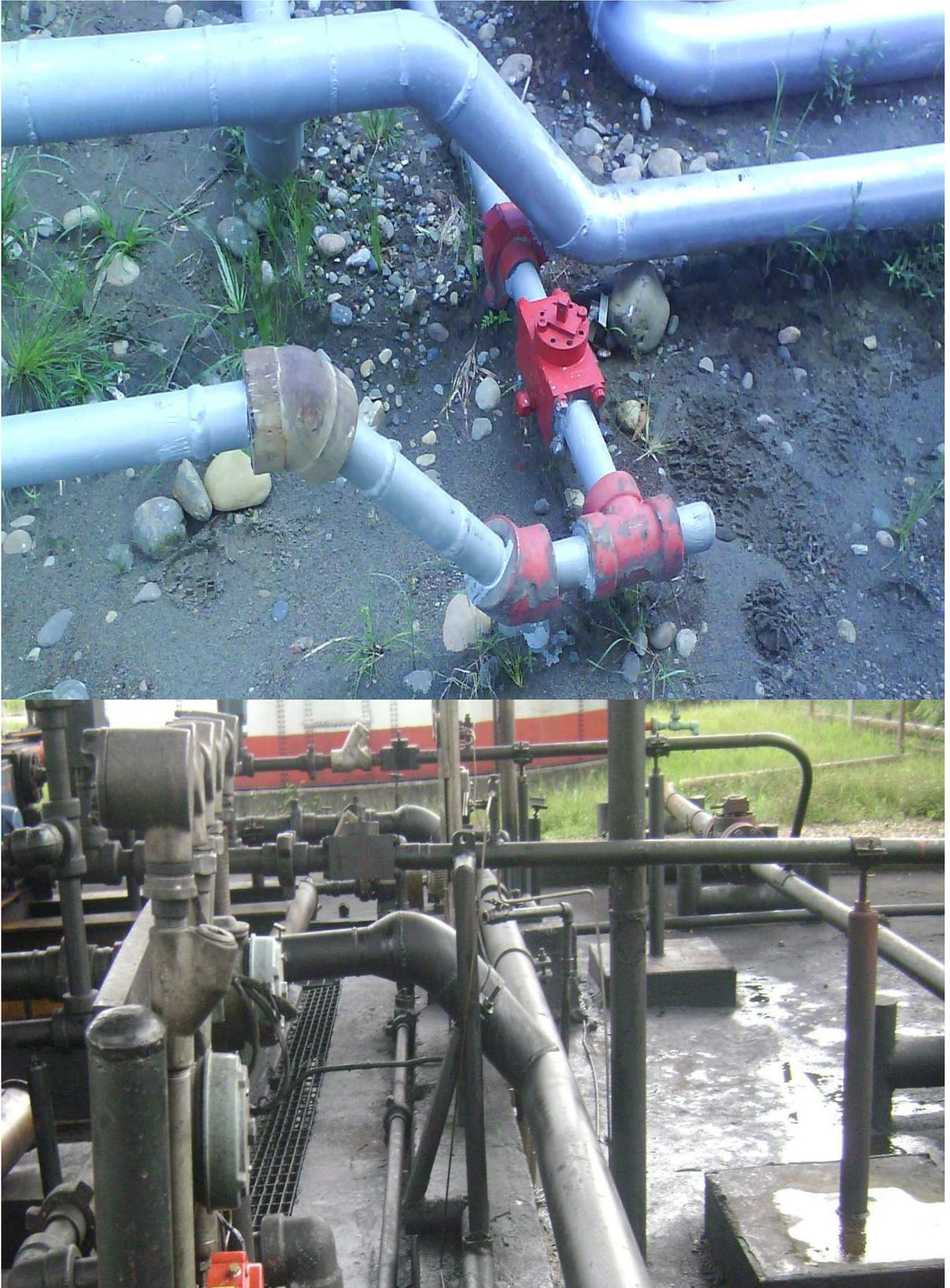
**Figura 3.6 Foto de conexiones improvisadas**
