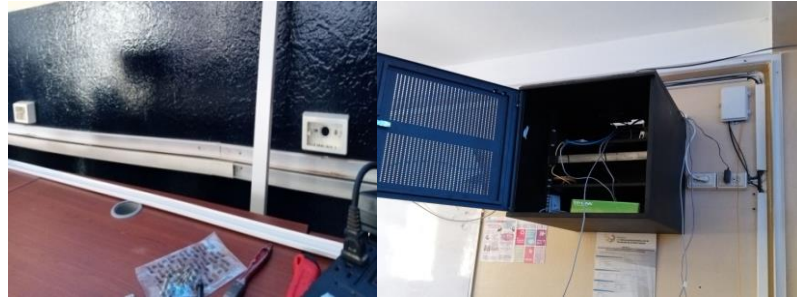
Aplicación de canaletas
