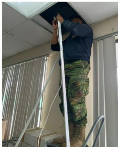
*Nota:* Cableado de red UTP CAT5 25 m. por medio de canaleta y sobre techo del laboratorio de comunicaciones.
