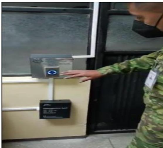
*Nota.* Se verifica el botón de salida instalado en la parte interior del laboratorio de comunicaciones el cual es un sensor por lo que no necesita presión para activarlo.
