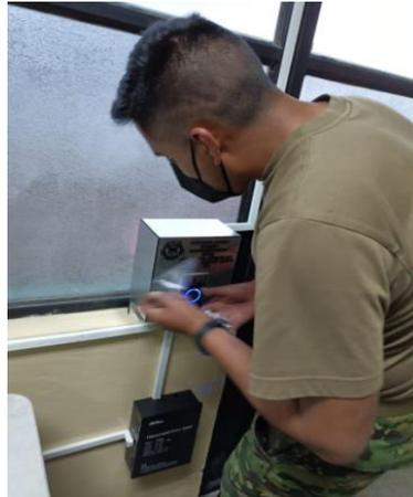
*Nota:* Alojamiento de caja fija contenedora de control de acceso DS-K1T8003EF y botón sensor de salida.
