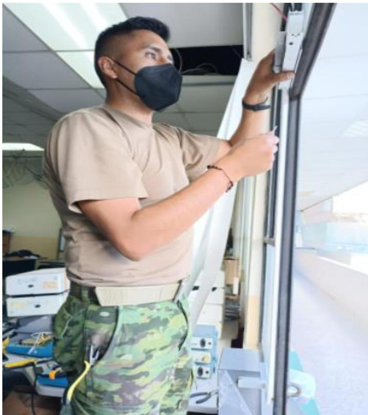
*Nota:* instalación fija de cerradura magnética AL-280 Led en puerta de metal con ángulos z.
