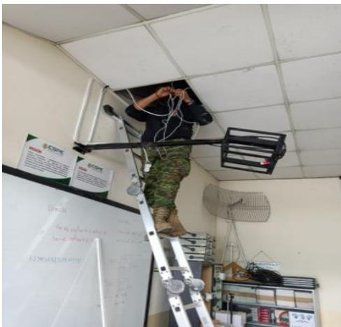
*Nota:* Se realiza un punto de conexión eléctrico dejando un toma corriente para la alimentación del cargador de 12v para la cámara IP.
