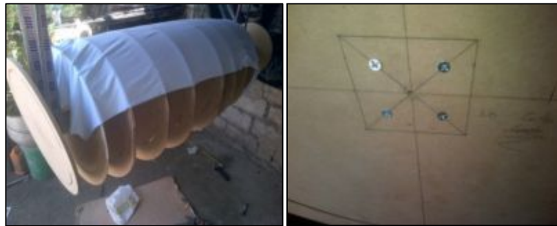
Figura 51. Montaje de los mamparos
