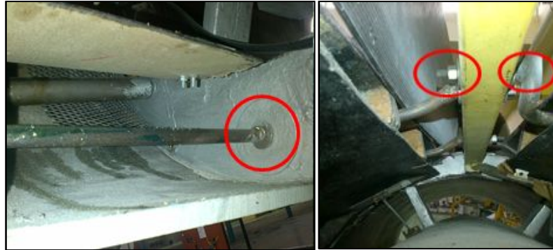
Figura 67. Montaje de los rieles superiores e inferiores
