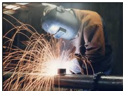
Figura 2.39 Soldadura de arco
