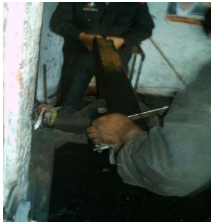
Fig. 4.9 Corte de las columnas
