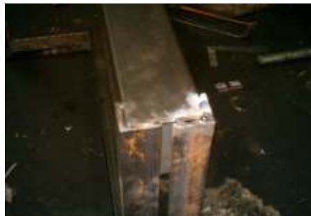
Fig. 4.15 Columnas sujetadas a los travesaños
