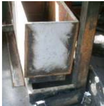
Fig. 4.14 Columnas sujetadas a la base
