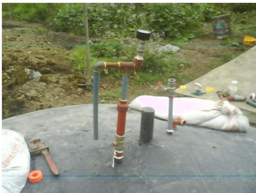
Fotografía 6.40: Acople de la Botella en la Tubería de la Línea de Salida del Biogás
