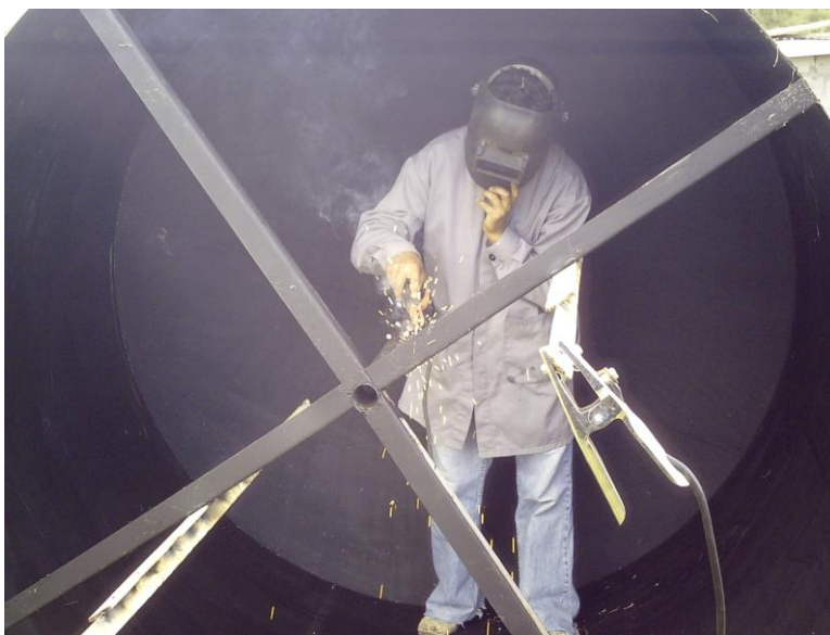
Fotografía 6.30: Colocación de Refuerzos en el Interior de la Campana
