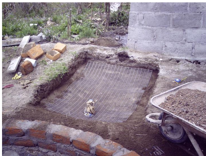
Fotografía 6.35: Cimentación del Tanque de Carga.
