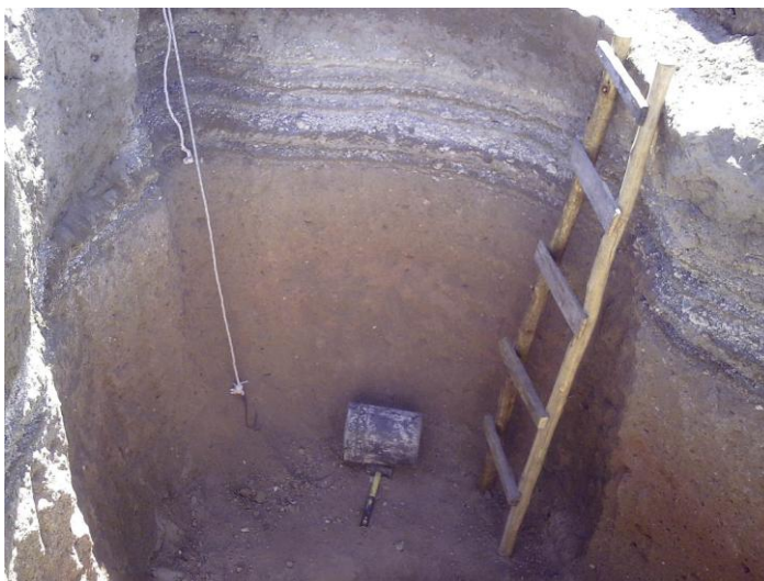
Fotografía 6.7: Comprobación de la Perpendicularidad del Pozo.
