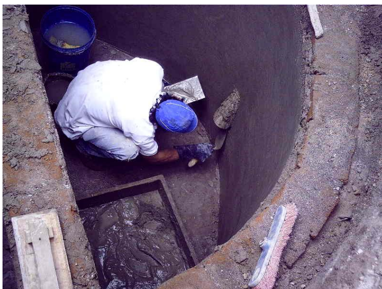
Fotografía 6.27: Enlucido de la Parte Interna del Biodigestor.
