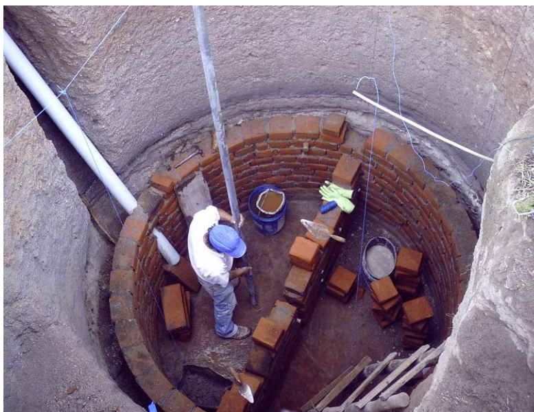
Fotografía 6.20: Colocación del Tubo Guía para el Gasómetro.
