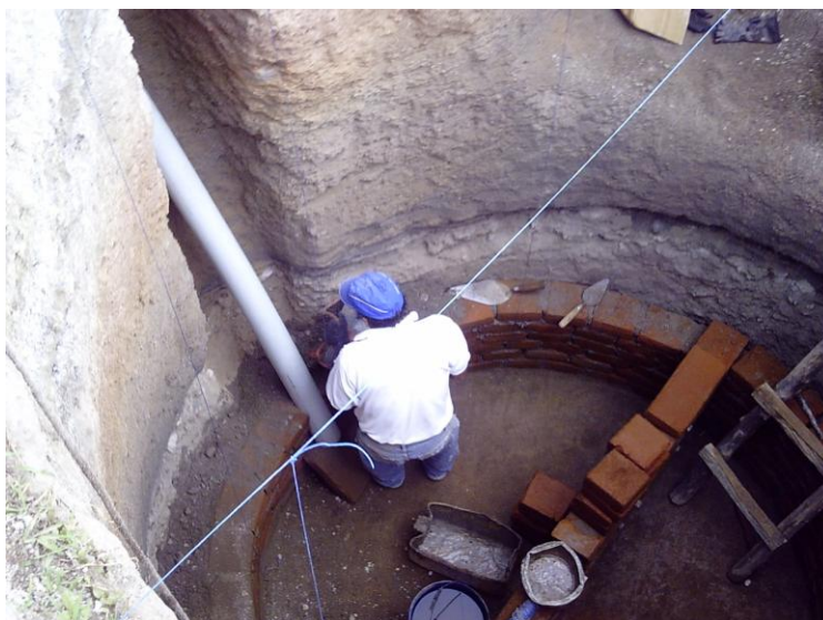
Fotografía 6.19: Ensamblaje de los Tubos de Carga y Descarga.
