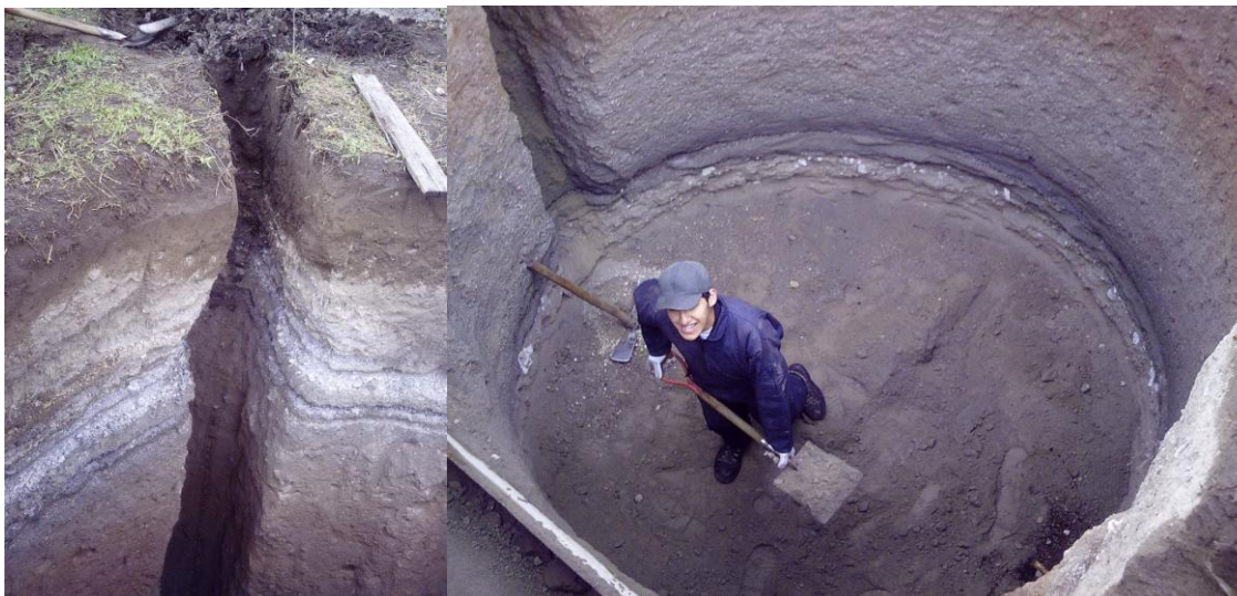
Fotografía 6.8: Excavación de Trincheras para los Tubos de Carga y Descarga.
