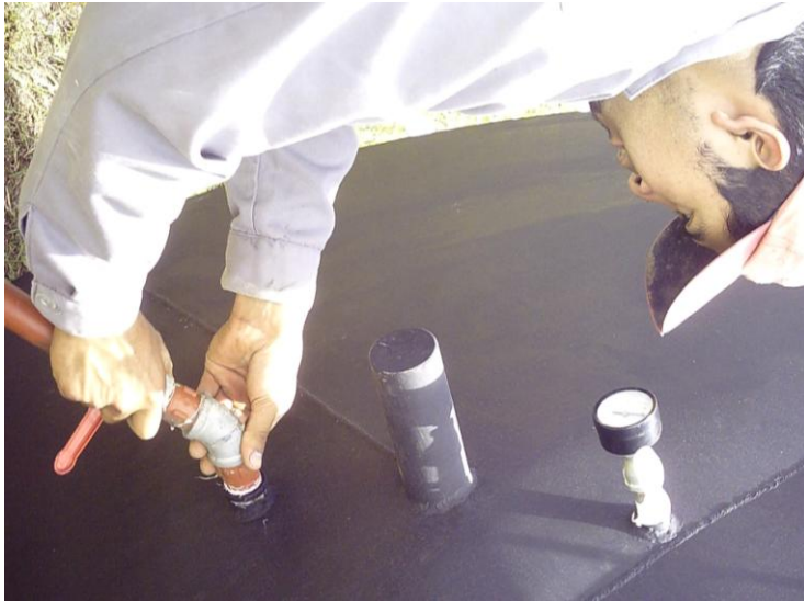
Fotografía 6.42: Colocación de la Tubería para la Salida del Biogás.
