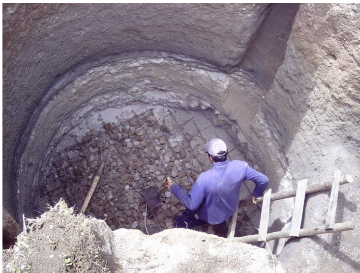
Fotografía 6.9: Colocación de la Piedra Bola en el Fondo del Biodigestor.
