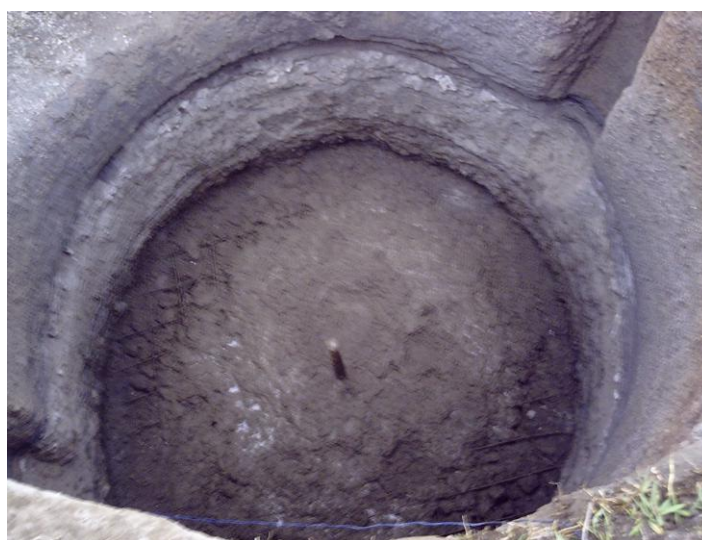
Fotografía 6.15: Fundición del Piso con La Mezcla de Concreto
