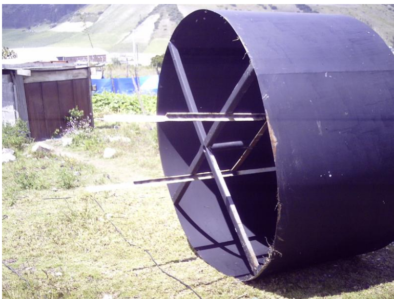
Fotografía 6.31: Colocación de Platinas en Forma de L en el Interior del Gasómetro.
