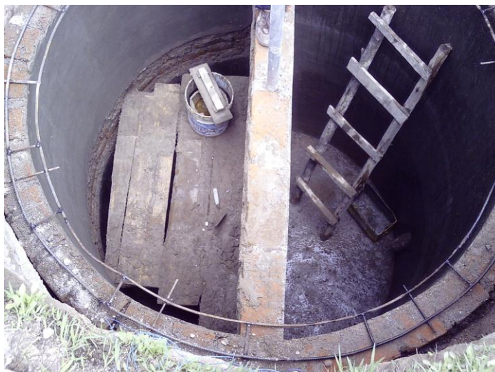
Fotografía 6.23: Colocación de la Malla para la Base de la Ceja.
