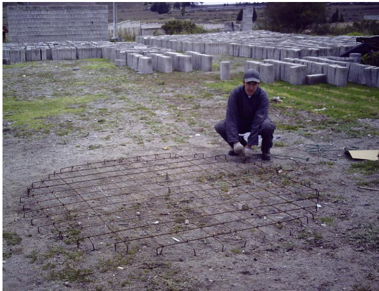
Fotografía 6.11: Conformación de la Malla de Varilla de 10 mm.
