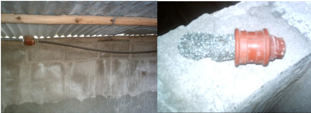
Fotografía 6.43: Construcción del Filtro para Eliminación de S_2H
