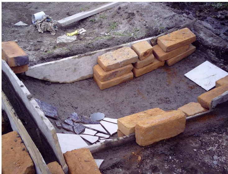
Fotografía 6.37: Colocación de los Ladrillos en la Caja de Carga.
