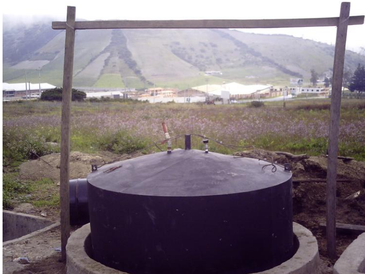
Fotografía 6.41: Pórtico Utilizado para Colocación de la Campana.
