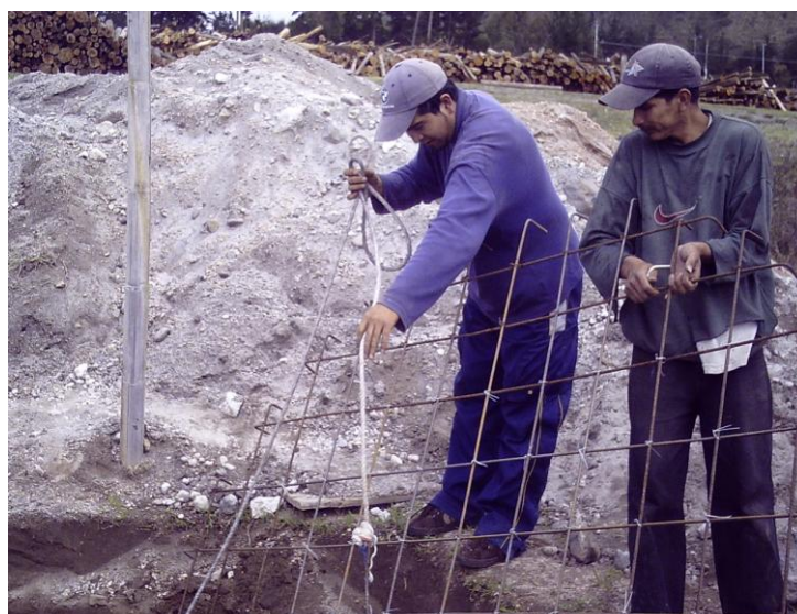
Fotografía 6.13: Colocación del Mallado Dentro del Biodigestor.
