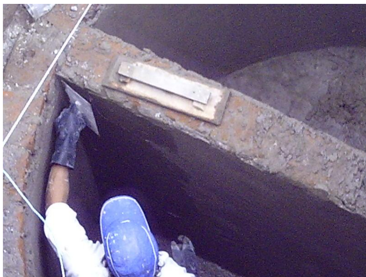
Fotografía 6.28: Alisado de la Parte Interna del Biodigestor.
