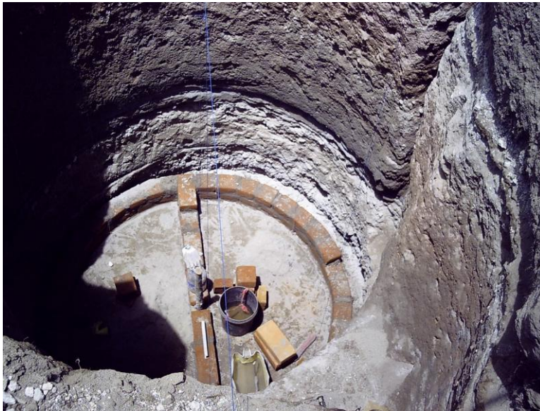
Fotografía 6.16: Construcción de la Pared Externa y Pared Divisora
