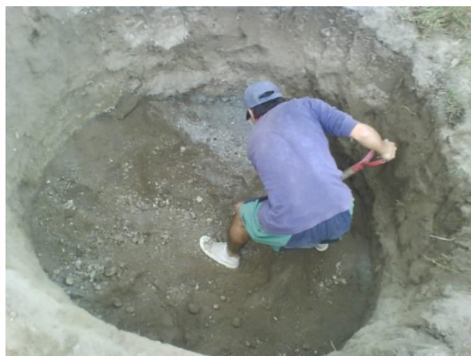
Fotografía 6.6: Excavación del Terreno.
