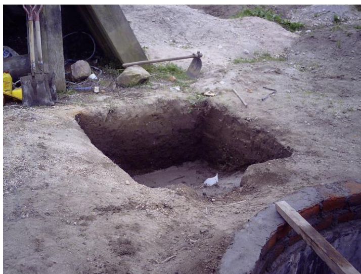
Fotografía 6.36: Excavación de la Caja de Descarga.
