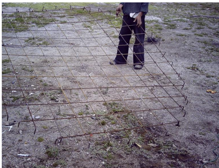
Fotografía 6.12: Malla de Varilla Terminada.
