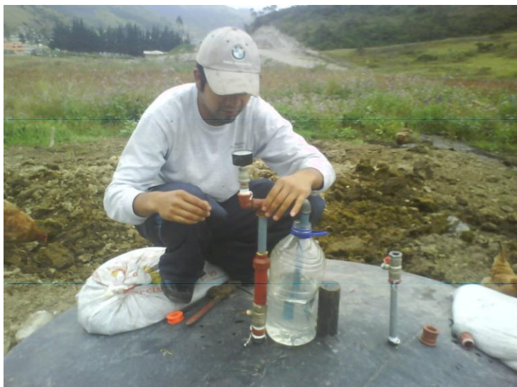
Fotografía 6.39: Material de la Válvula de Seguridad
