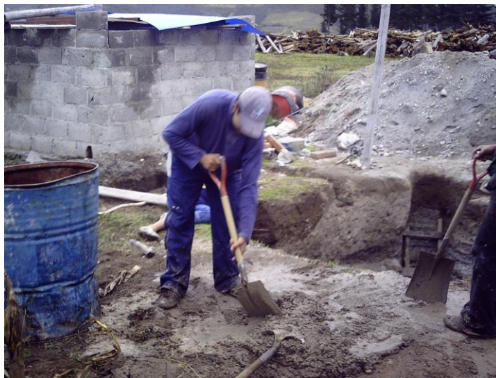
Fotografía 6.14: Preparación de la Mezcla para La Fundición del Piso.
