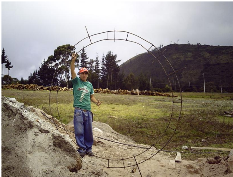
Fotografía 6.22: Malla Soldada para Base de la Ceja.
