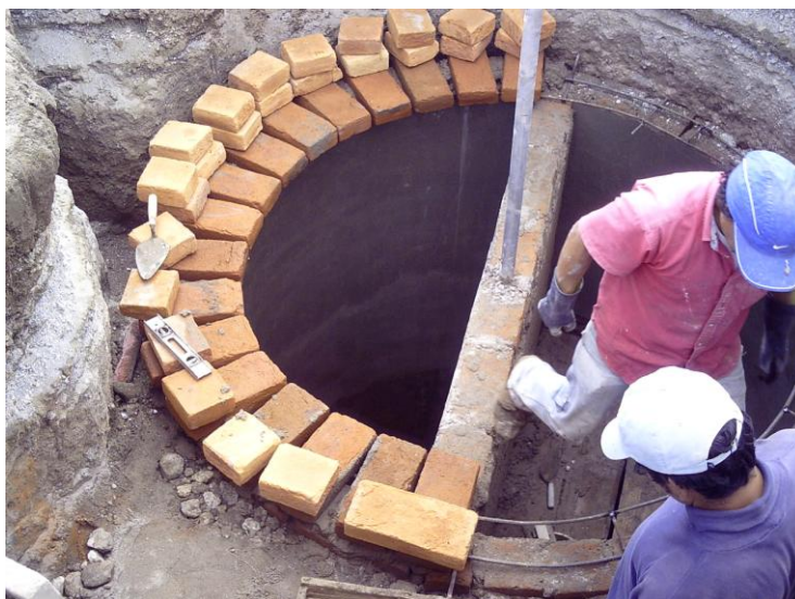
Fotografía 6.24: Colocación de los Ladrillos Transversales para la Ceja.
