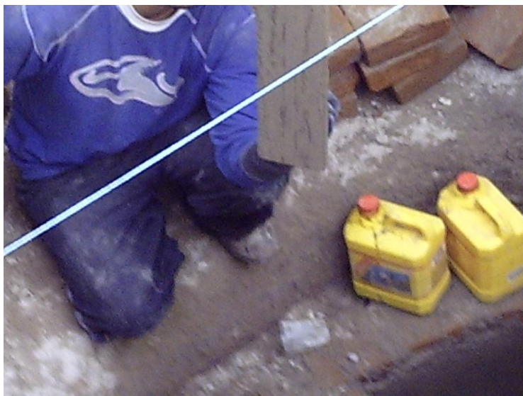
Fotografía 6.26: Sika Utilizado para el Enlucido el Biodigestor.
