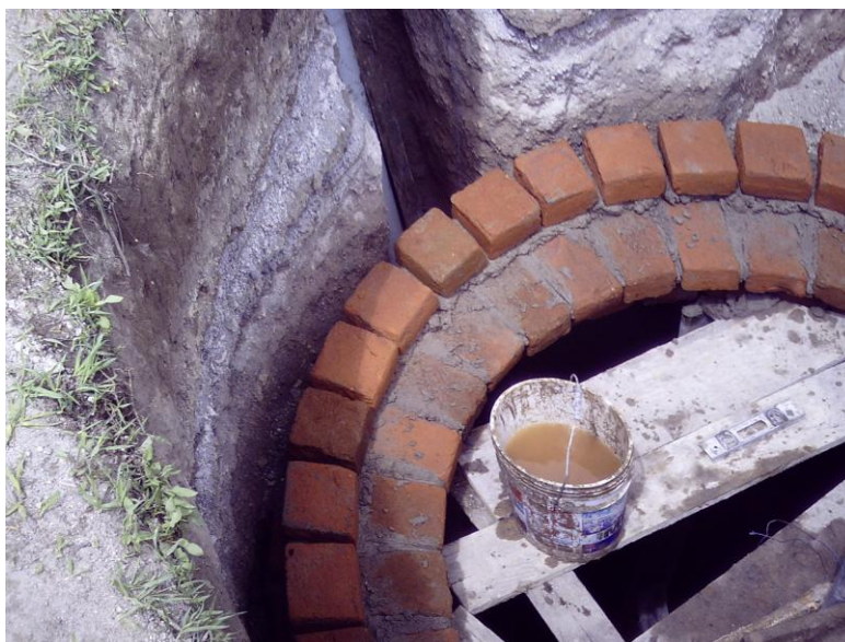
Fotografía 6.25: Colocación de la Primera Fila de Ladrillo Después de la Ceja.
