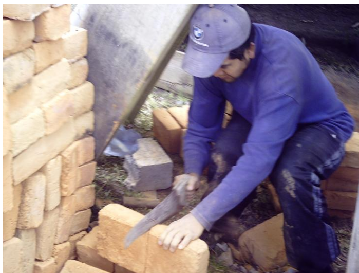
Fotografía 6.17: Corte de Ladrillos para las Paredes del Digestor.
