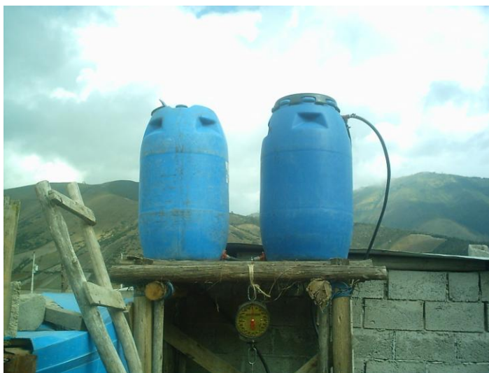
Fotografía 6.4: Tanques de Reserva de Agua.
