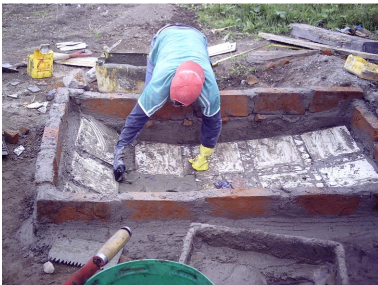
Fotografía 6.38: Colocación de la Cerámica en la Caja de Carga.
