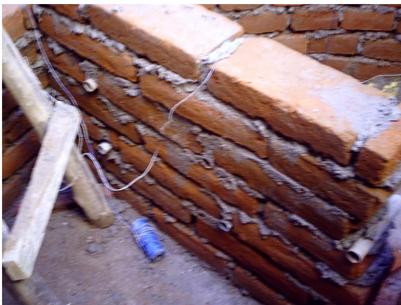
Fotografía 6.18: Orificios de la Pared Divisora.
