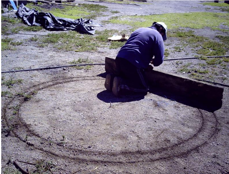
Fotografía 6.21: Trazado del Mallado para Soporte de la Ceja.
